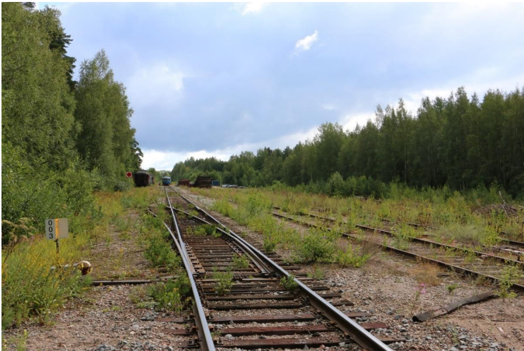
Kuva 33. Vierumäen infrastruktuuria. Etualalla läpikulkuraide 002. Kuvassa oikealla liikenteeltä suljetut raiteet 003 ja 004, jotka ovat likimain purkukuntoisia. Kuva: Aapo Halminen.
