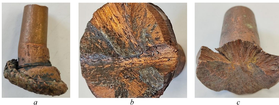
Рис. 1. Внешний вид электродов после выхода их из строя по причине: a – деформации; b – износа и загрязнения; c – разрушения
