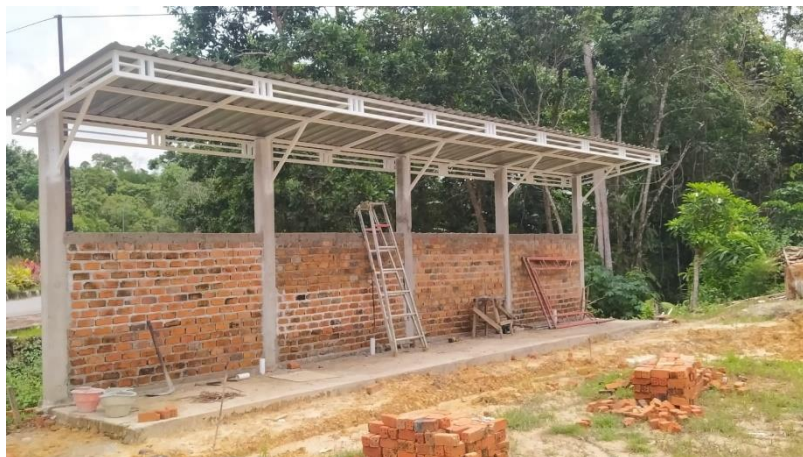
Gambar 9. Hasil Pekerjaan Atap
