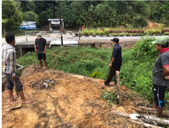
Gambar 6. Pengukuran dan Pemasangan Bowplank pada Area Lokasi Pembangunan
