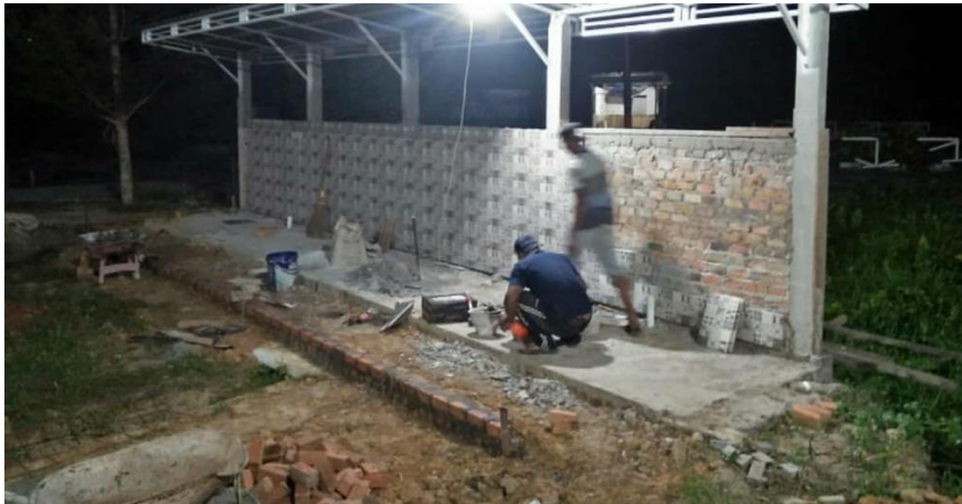
Gambar 10. Pemasangan Keramik
