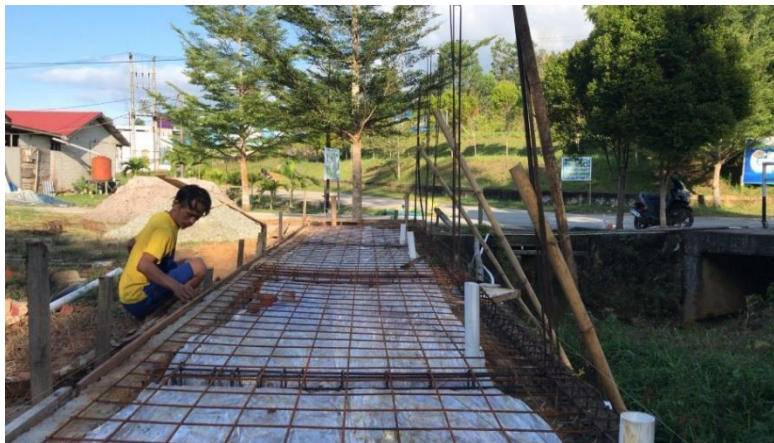
Gambar 7. Pembesian dan Pemasangan Bekisting Pelat Lantai
