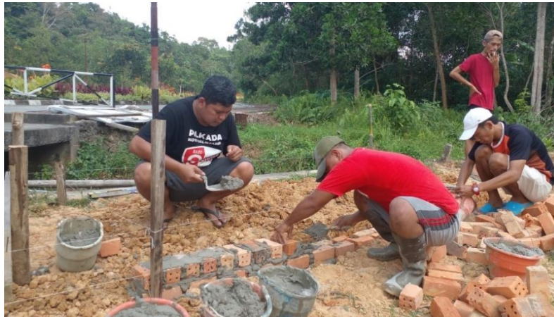
Gambar 8. Pemasangan Dinding
