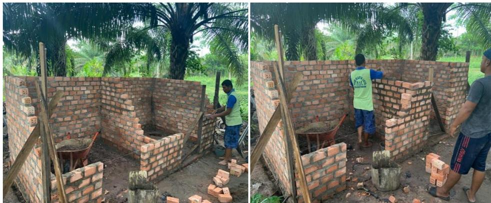
**Gambar 4.** Proses Pembuatan Bak Kompos
