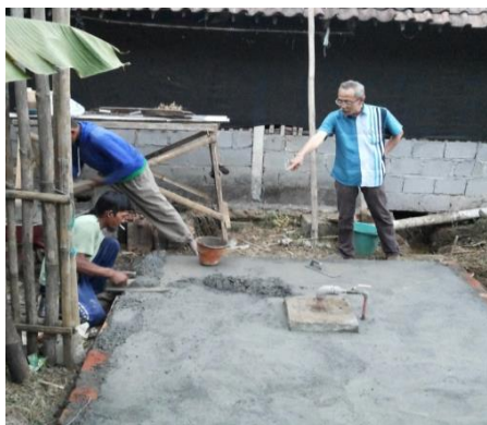
Gambar 3. Renov. digester Biogas
