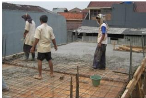
Gambar 2. Pengecoran plat atap beton bertulang (sumber: https://dbestkontraktor.com/ )
