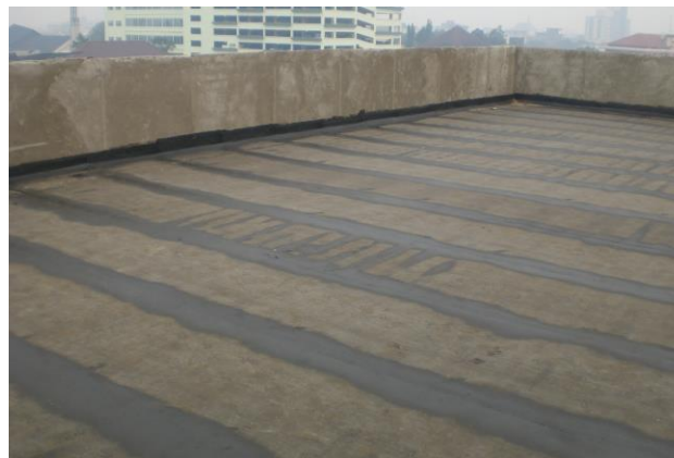
Gambar 13. Pemasangan waterproofing membrane (sumber: penulis, 2021)
