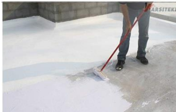
Gambar 12. Pemasangan waterproofing coating (sumber: indojavaepoxy.com)
