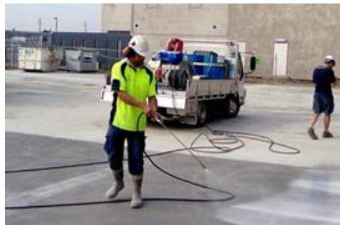
Gambar 6. Curing beton dengan meyiramkan air secara berkala (sumber : https://lauwtjunnji.weebly.com/curing-beton.html )
