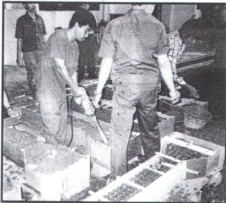
Gambar VIII.2 Pengecoran benda uji kolom
