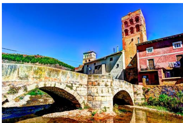
Imagen 10. Puente de piedra.
