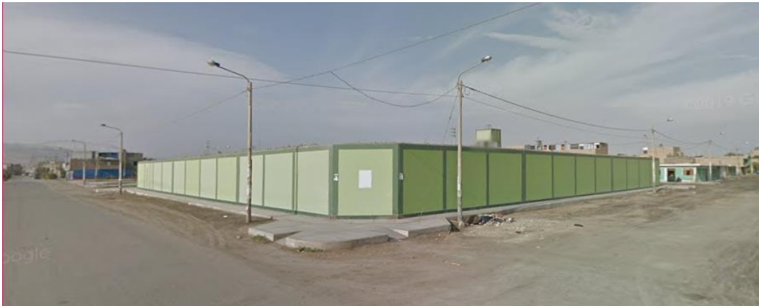
Figura 31: vista del contexto Jr.28 de julio
