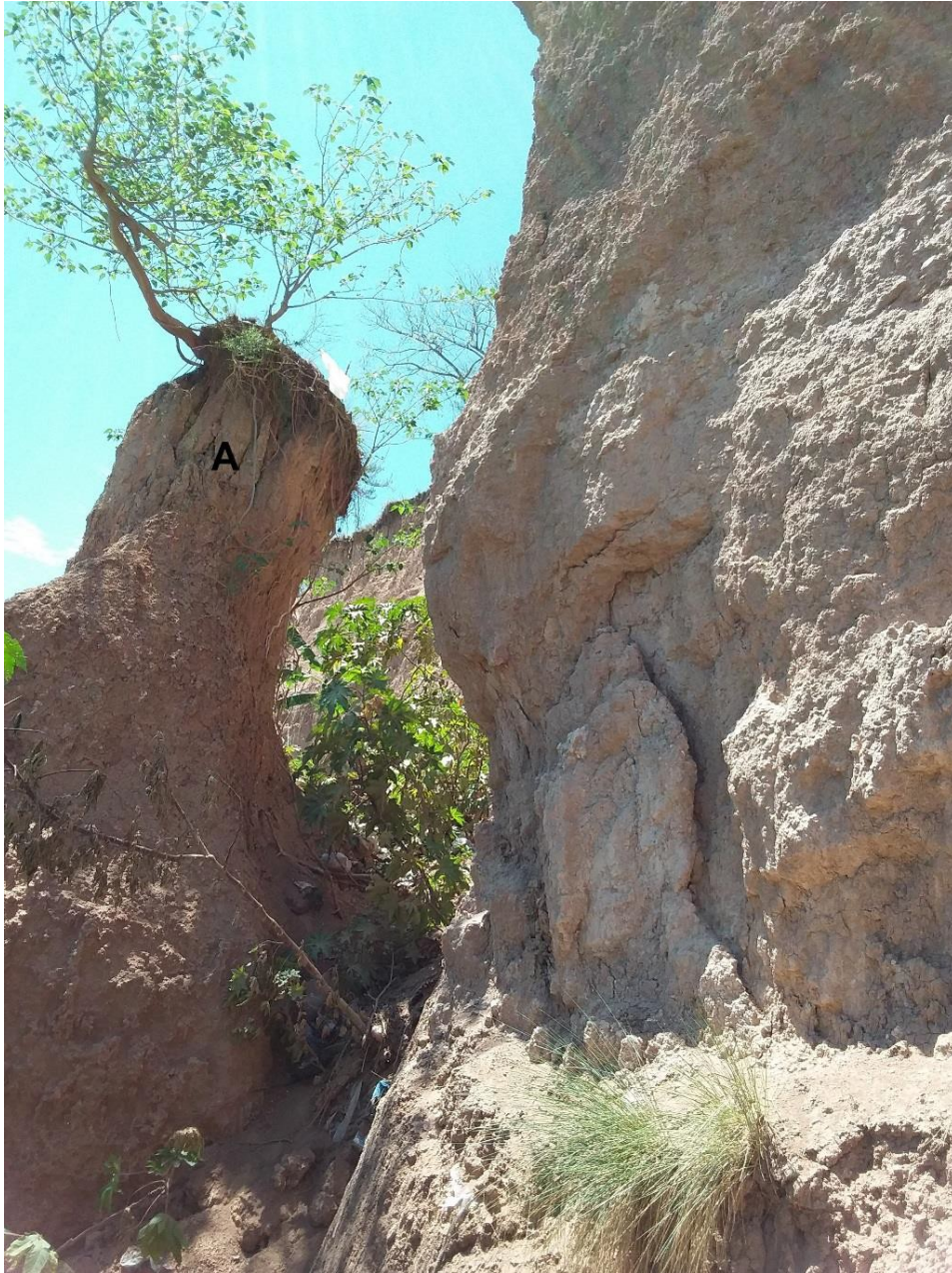
Figura 18. Antiguo bloque descendido en la barranca (A), donde se puede apreciar la rotación hacia atrás en dirección de la antigua escarpa de arranque, representada actualmente por la barranca.
