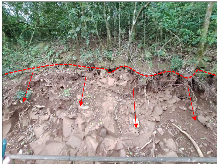
Figura 9. Deslizamientos irregulares de rocas en la Estación N°3. Nótese el plano de ruptura irregular. Las flechas rojas indican la dirección del movimiento.
