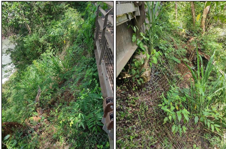
Figura A1.10. Izquierda: vista general de la zona de deslizamiento. Derecha: Vista en detalle del proceso de socavación de la base de la fundación y de la malla metálica utilizada para mitigarlo.
