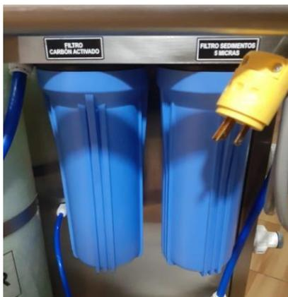
Figura 58. Filtro de carbón y 5 micras terminado
