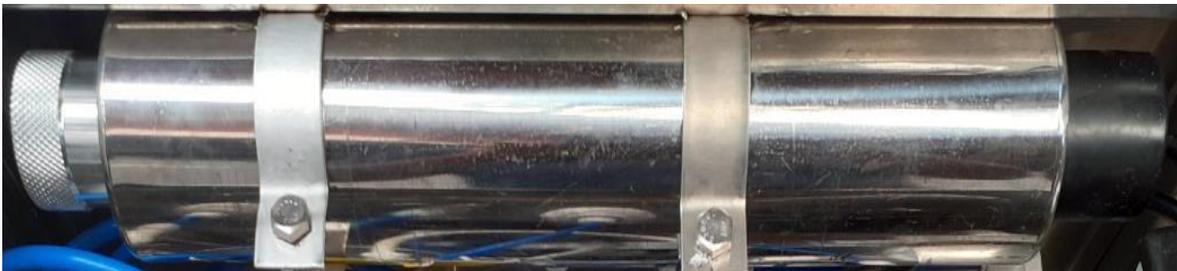
Figura 44. Lámpara UV 2GPM 16W ensamblada en el sistema
