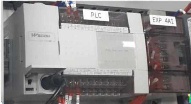
Figura 69. PLC y EXP 4AI conectados
