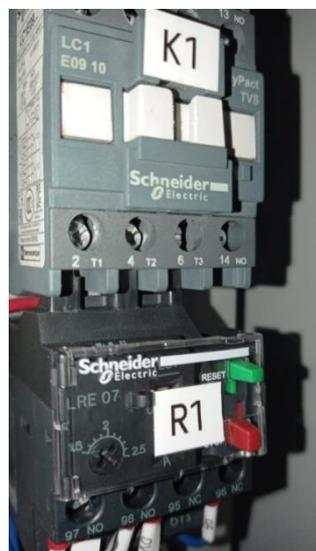
Figura 68. Contactor y relé térmico vinculados
