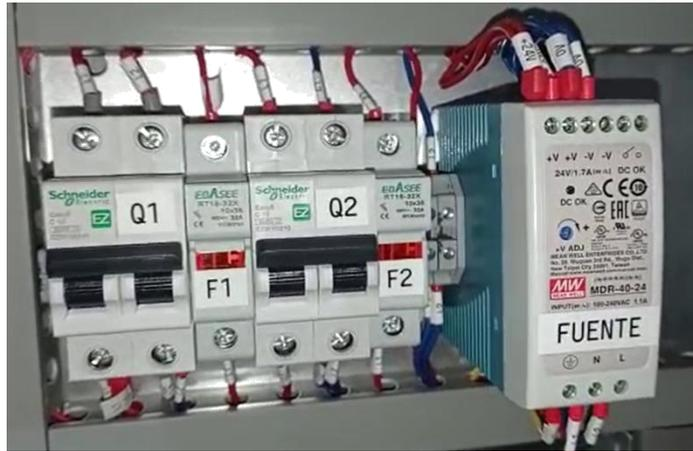
Figura 67. Interruptores y fuente de conversión a 24 v DC
