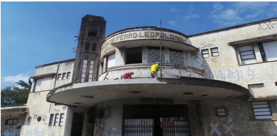
Foto 2 – Vista frontal da Estação Ferroviária Leopoldina.
