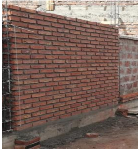
Ilustración 2 Asentamiento de ladrillo de soga
