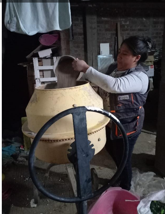
Dosificación de AGREGADO para una tanda
