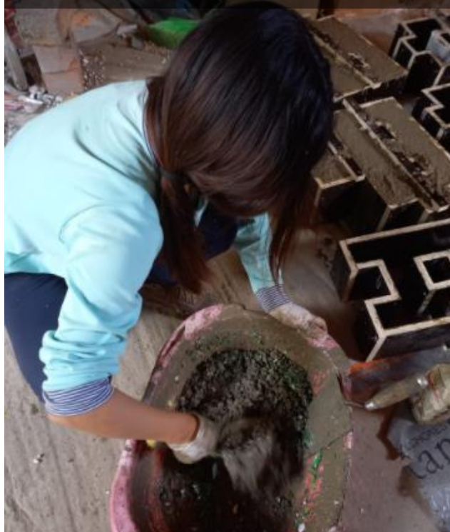
Verter Mezcla en los Moldes
