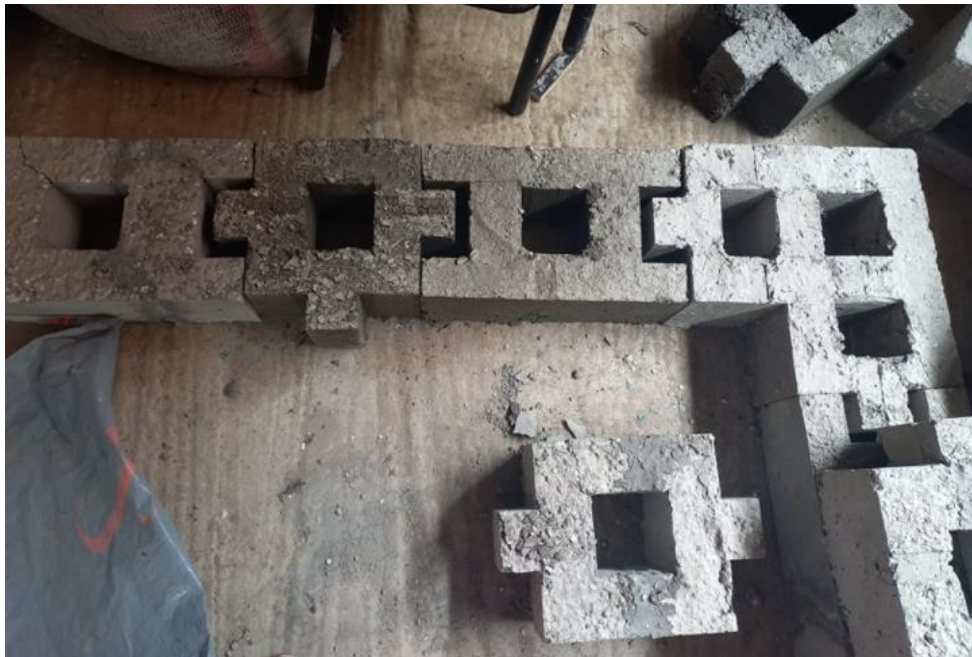
Armado de una hilera con ladrillos PET
