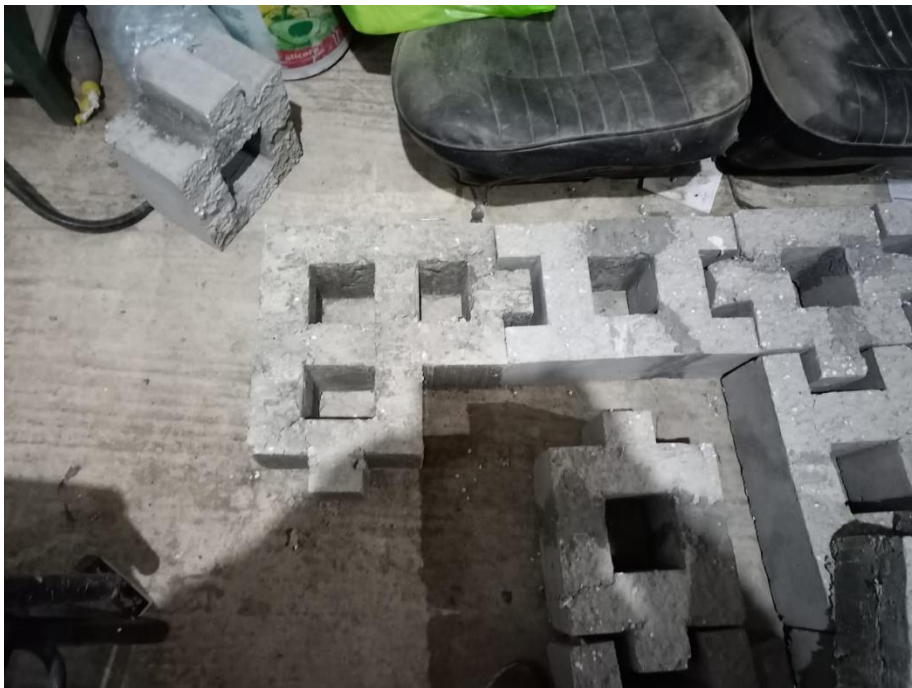
Ilustración 21 Asentamiento de muro con ladrillo PET
