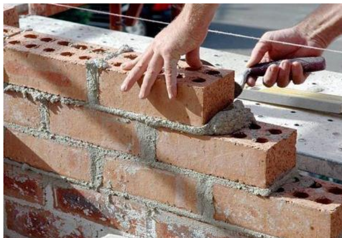
Ilustración 3 Nivelación de asentamiento de ladrillo
