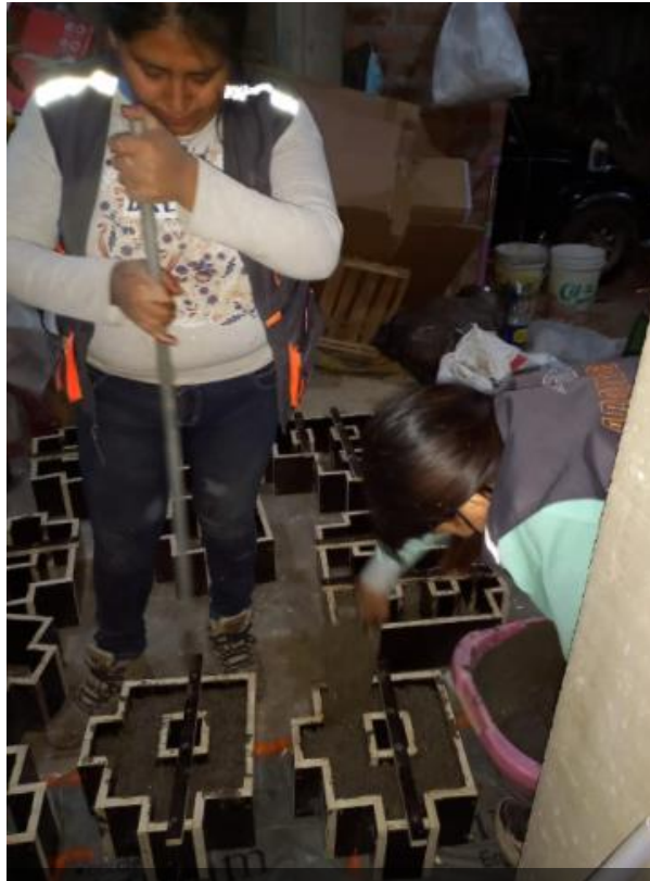
Vibra y compactar la Mezcla
