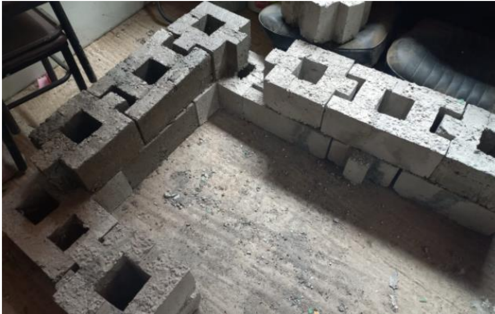
Armado de dos hileras con ladrillos PET
