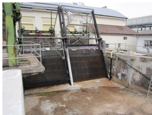
Abb. 14: Links Vertikalrechenquerschnitt mit dem zur Sohle geneigten Winkel \alpha ( Quelle: verändert nach Giesecke, 2009 ). Rechts Foto des Vertikalstabrechens am WKW Ottenu vor den beiden Maschineneinläufen.
