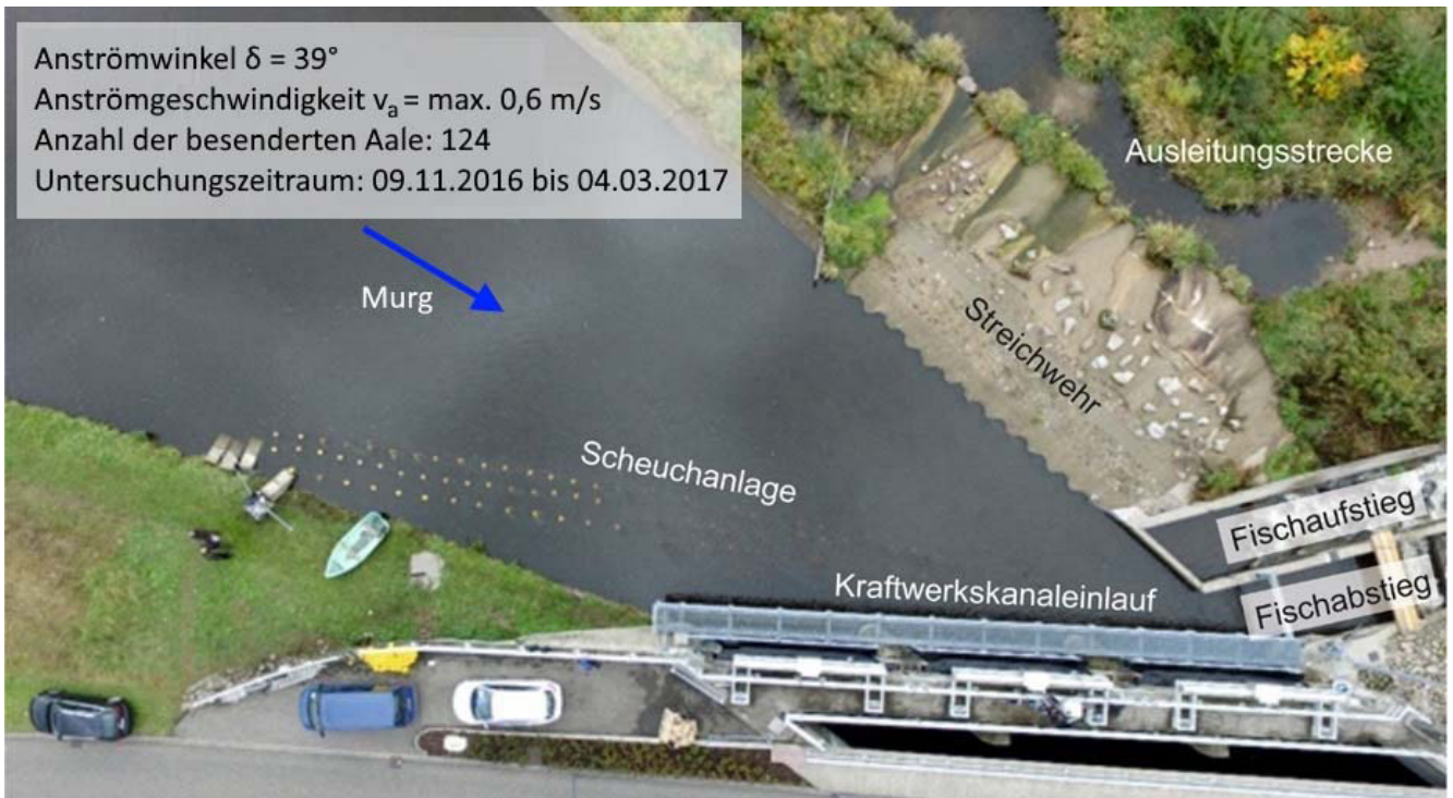
Abb. 174: Luftbild des Einlaufbereichs Rotenfels mit Streichwehr, Fischauf- und -abstiegsanlage und eingebauter Scheuchanlage (Quelle: verändert nach Google.maps).
