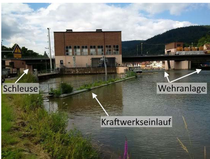
Abb. 93: WKW Hirschhorn mit seiner Lage zwischen der Wehranlage und der rechten Schleusenkommer des Wasser- und Schifffahrtsamtes ohne Möglichkeit zur Vergrößerung des Querschnitts vor den Maschineneinläufen.
