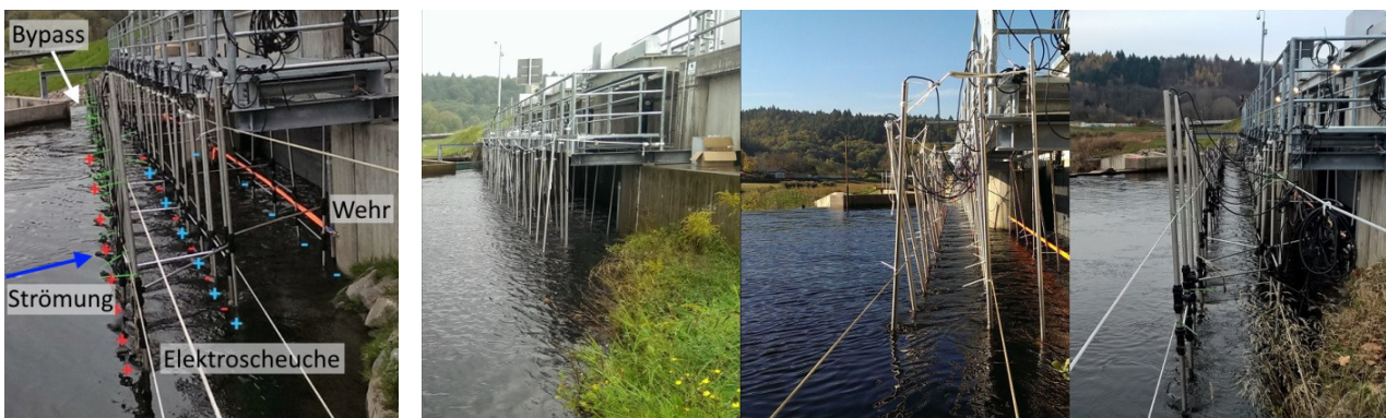
Abb. 178: Elektroscheuchanlage in Rotenfels im Jahr 2015 mit Elektroden, welche an Seilen und Fixierungsseilen befestigt waren (links). Die rechten drei Bilder zeigen die Veränderungen an der Elektroscheuchanlage von 2014 nach 2015: Der linke Zustand zeigt die Elektroscheuchanlage von 2014, das mittlere Bild die zusätzlichen Fixierungsseile, das rechte Bild die Verstrebungen der einzelnen Elektroden untereinander (Quelle: verändert nach Weibel et al. , 2015a).
