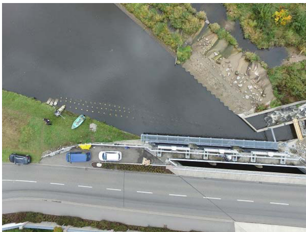
Abb. 176: Luftbild der Fischeicheuchanlage in Rotenfels.
