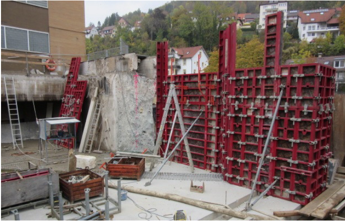
Abb. 94: Verlängerung des Mittelpfeilers am WKW Künzelsau zum Einbau eines Schrägrechens mit Anströmwinkel von 42^\circ , Anströmgeschwindigkeit von 0,8 \text{ m/s} und einem Stababstand von 15 \text{ mm} . Links während des Baus mit Systemschalung für Pfeilerverlängerung und rechts im ausgeschalteten Zustand sowie mit fertiger Sohlensiche zum Einbau des Schrägrechens.
