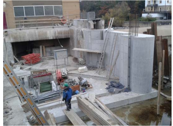
Abb. 94: Verlängerung des Mittelpfeilers am WKW Künzelsau zum Einbau eines Schrägrechens mit Anströmwinkel von 42^\circ , Anströmgeschwindigkeit von 0,8 \text{ m/s} und einem Stababstand von 15 \text{ mm} . Links während des Baus mit Systemschalung für Pfeilerverlängerung und rechts im ausgeschalteten Zustand sowie mit fertiger Sohlensiche zum Einbau des Schrägrechens.
