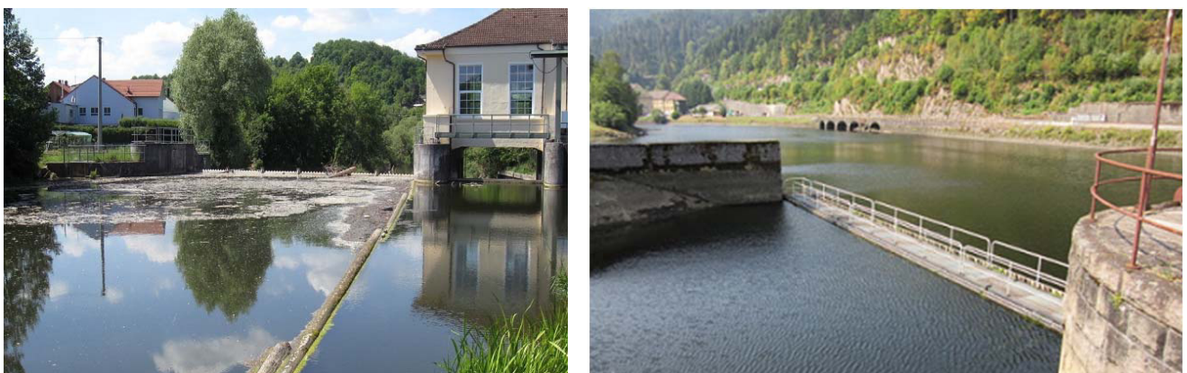
Abb. 6: Geschwemmselbalken aus Holz am WKW Siglingen (links) und begehbarer und höhenverstellbarer Stahlgchwemmselbalken am Niederdruckwerk Forbach (rechts).
