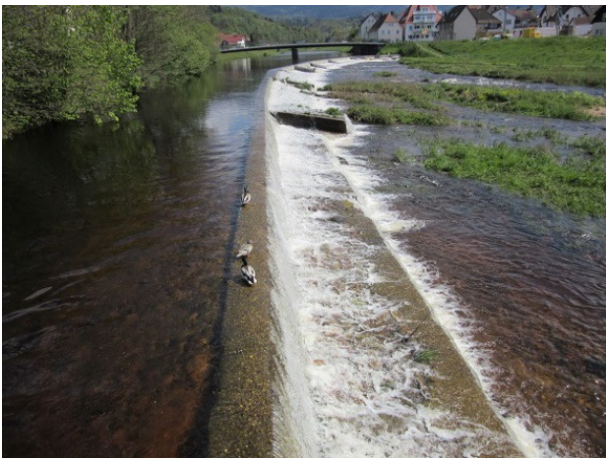
Abb. 131: Kurzzeitiger Streichwehrüberfall (ggf. durch Sunk und Schwall der Oberliegerkraftwerke hervorgerufen) am Streichwehr in Ottenau zu Versuchsbeginn am 04.05.2017.
