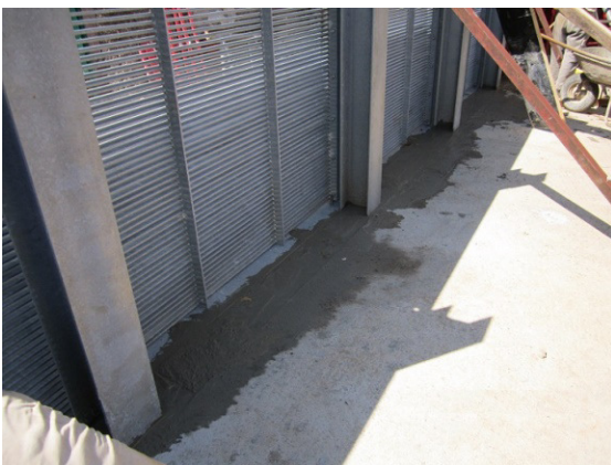
Abb. 26: Links Rechenfelder des Schrägrechens am WKW Ottenau mit Blick auf die uw-seitige Rechenebene (Quelle: EnBW, 2012). Rechts Rechenfelder des Schrägrechens im wasserbaulichen Forschungslabor.
