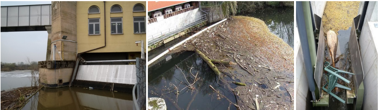
Abb. 23: Geschwemmsel-, Laub- und Geästandrang am WKW Ladenburg am Neckar (links) und am WKW Mühlhausen an der Enz (Mitte) sowie am Schrägrechen des WKW Künzelsau im Frühjahr mit großen Holzstämmen und Zivilisationsmüll (rechts).
