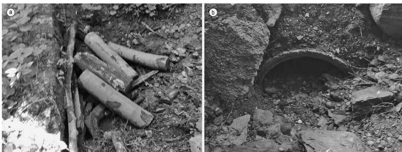
Slika 9a i 9b. Otežana funkcionalnost vodopropusnih objekata Fig. 9a and 9b Aggravated functionality of water-permeable structures
