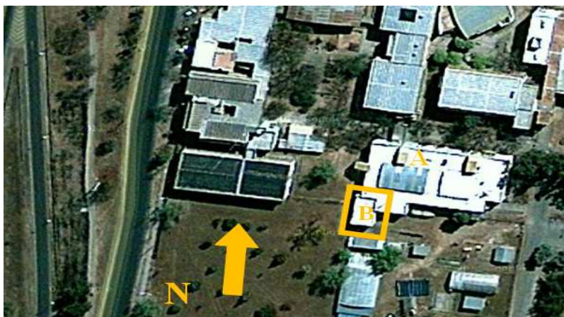
Figura 1: A - Primera ubicación de la MCFVCR sobre el edificio de física en el campus de la U.N.Sa (Google maps, 2011) y B nueva ubicación sobre el sector PME 230.
