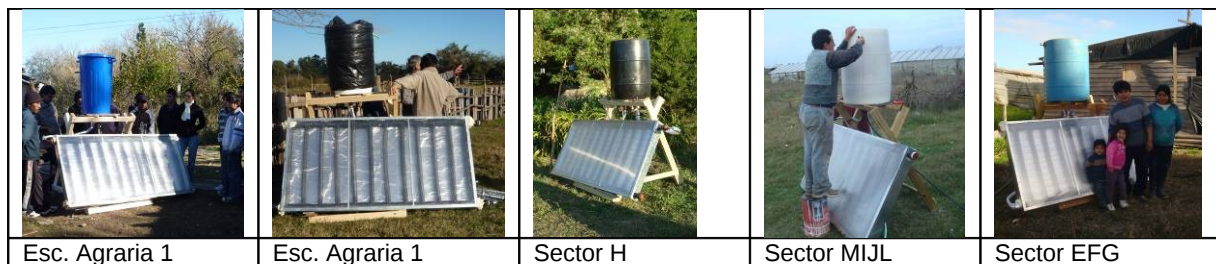
Instalación de equipos para calentamiento de agua en viviendas del PPI.
