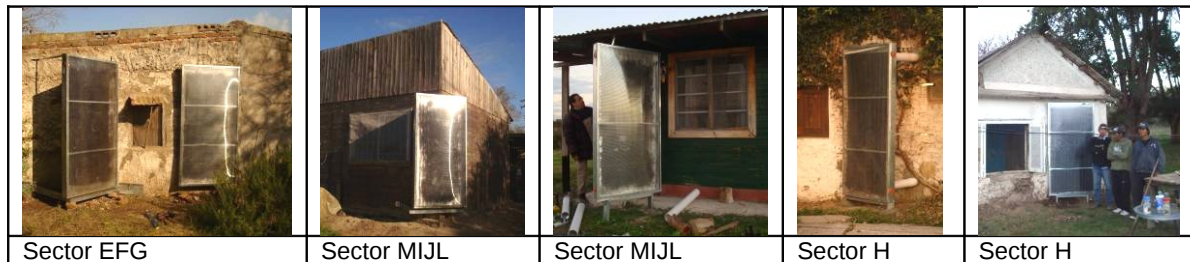
Instalación de equipos para calentamiento de aire en viviendas del PPI.
