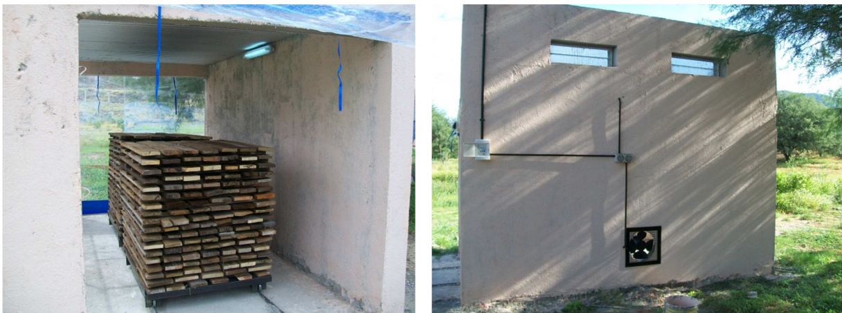
Figura 5. Vista del secadero cargado parcialmente y de la pared sur con el forzador de aire instalado
