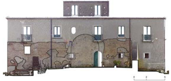
**Fig. 8 – Ortofoto + plano vectorial en AutoCAD.**
