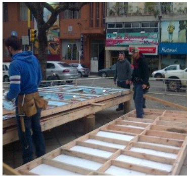
(A) Día 1: Panel de piso fijo – aislación telgopor – fenólico – piso parte plegable.
