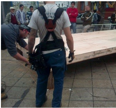
(A) Día 1: Panel de piso fijo – aislación telgopor – fenólico – piso parte plegable.
