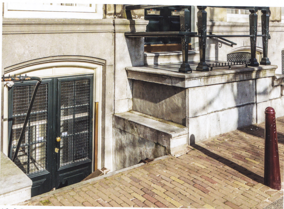
Afb. 5. De stoep van Herengracht 14 met de ingang tot het souterrain (foto: Wim Ruijgrok)
