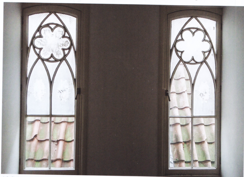
Afb. 7. Gotiserende vensters in het trappenhuis (foto: auteurs)
