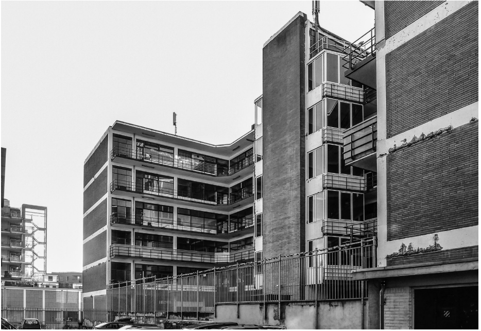
Afb. 2. De achtergevel van het bedrijvencentrum Westerpark. Foto auteurs.
