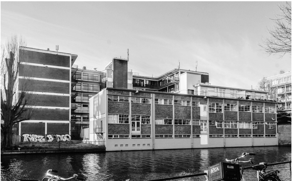
Afb. 3. Op de voorgrond de drukinktfabriek van Merkelbach & Karstens uit 1939. Daarachter het bedrijvencentrum Westerpark. Foto auteurs.
