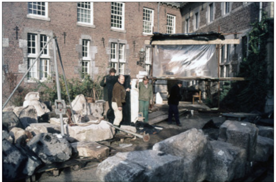
Afb. 5. Opname van de documentatiewerkzaamheden in 1974 van de stenen uit de Romeinse Maasbrug te Maastricht aan de achterzijde van het eerste Bonnefantenmuseum aan de Bonnefantenstraat te Maastricht.
