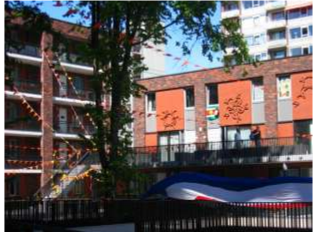
Leefdek Akropolishof: ook de voortuinen van de bovenwoningen en de galerijen van de flats kijken uit op het leefdek (foto genomen in de zomer).
