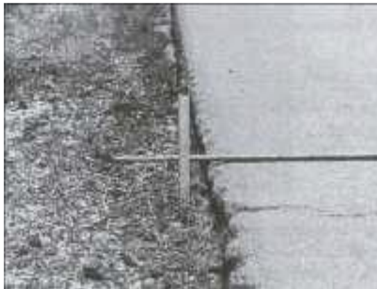
Gambar 2.28 Penurunan Lajur/Bahu Keparahan Tinggi (Sumber : pedoman PUPR)
