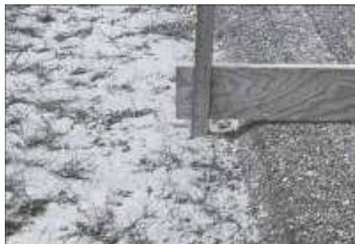
Gambar 2.26 Penurunan Lajur/Bahu Keparahan Rendah
