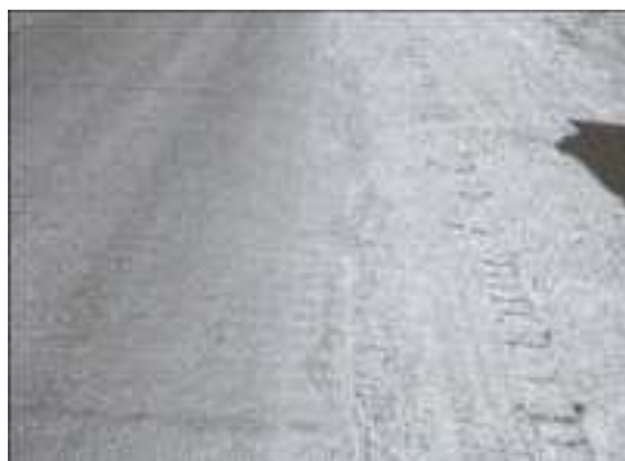
Gambar 2.23 Retak Refleksi Sambungan Keparahan Rendah
