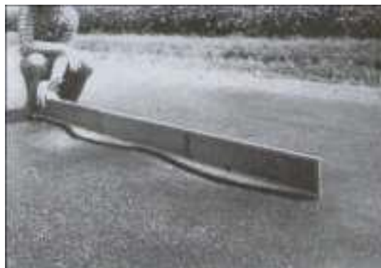
Gambar 2.16 Kerusakan Keriting Keparahan Tinggi
