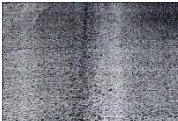
Gambar 2.47 Pelepasan Butir Keparahan Tinggi
