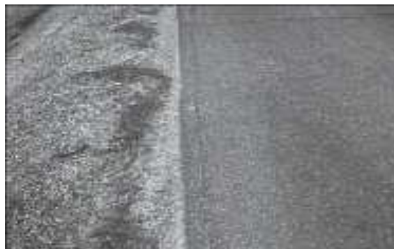
Gambar 2.20 Retak Tepi Dengan Keparahan Rendah
