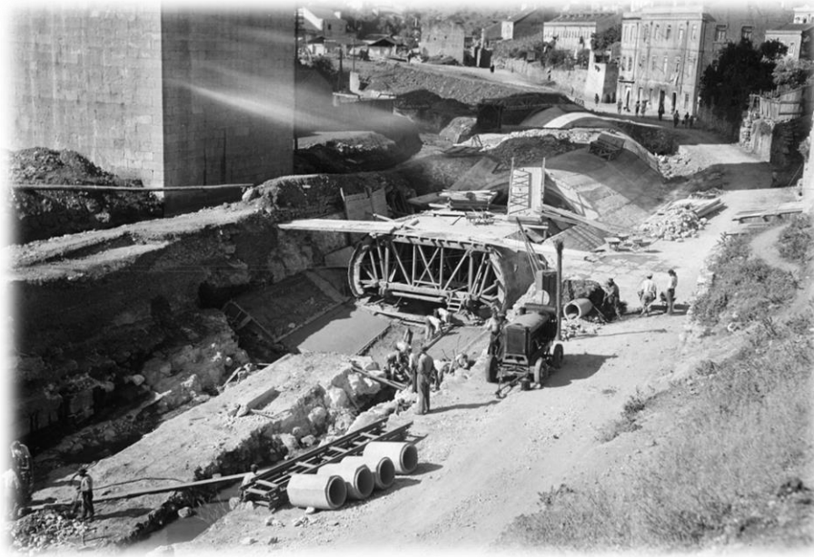
Figura 6.06. Obras de edificação do Caneiro de Alcântara (Fonte: Arquivo Municipal de Lisboa – PCSP-004-MAO-000676 – Folha 1 – CML, 2020)
