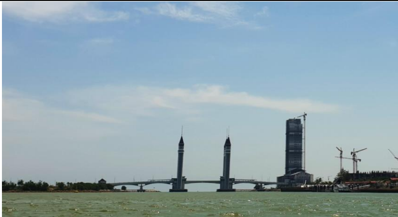
RAJAH 5. JAMBATAN ANGKUT KUALA TERENGGANU
