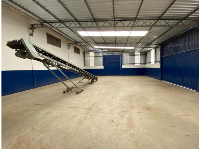
Figura 7 - Área de descarga para ração pronta Fonte: O próprio autor, 2021.
