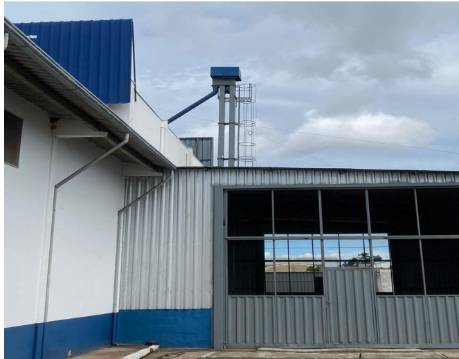
Figura 411 - Local de implementação do novo silo
