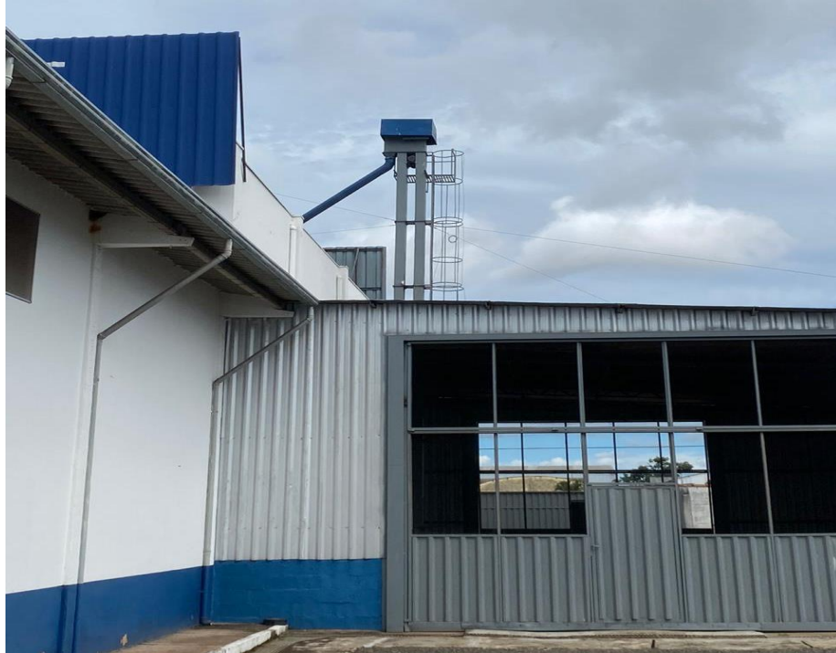
Figura 4 – Elevador de canecas exterior Fonte: O próprio autor, 2021
