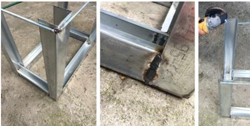
Figura 109- Remoção dos barrões metálicos e lixagem dos pontos de solda. Por Sr. Manuel Aberto. Fonte: Autora.
