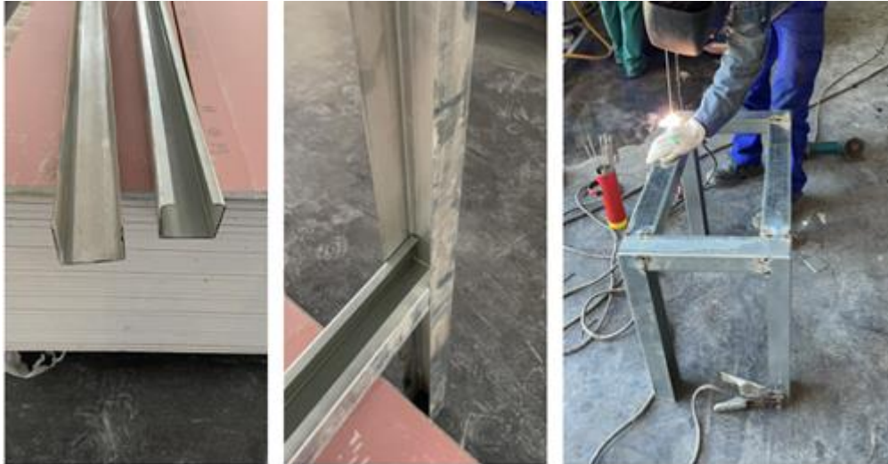
Figura 108- Corte do perfis metálicos e soldagem. Fonte: Autora.
