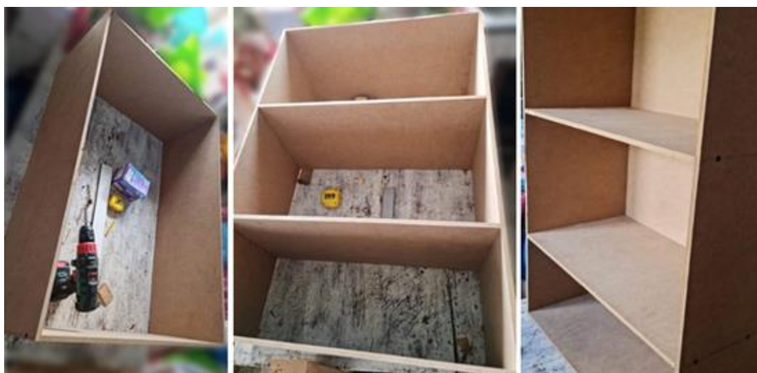
Figura 99- Ligação com parafusos da estrutura em forma de caixa (corpo do móvel). Execução: Sr. Manuel Alberto. Fonte: Autora.
