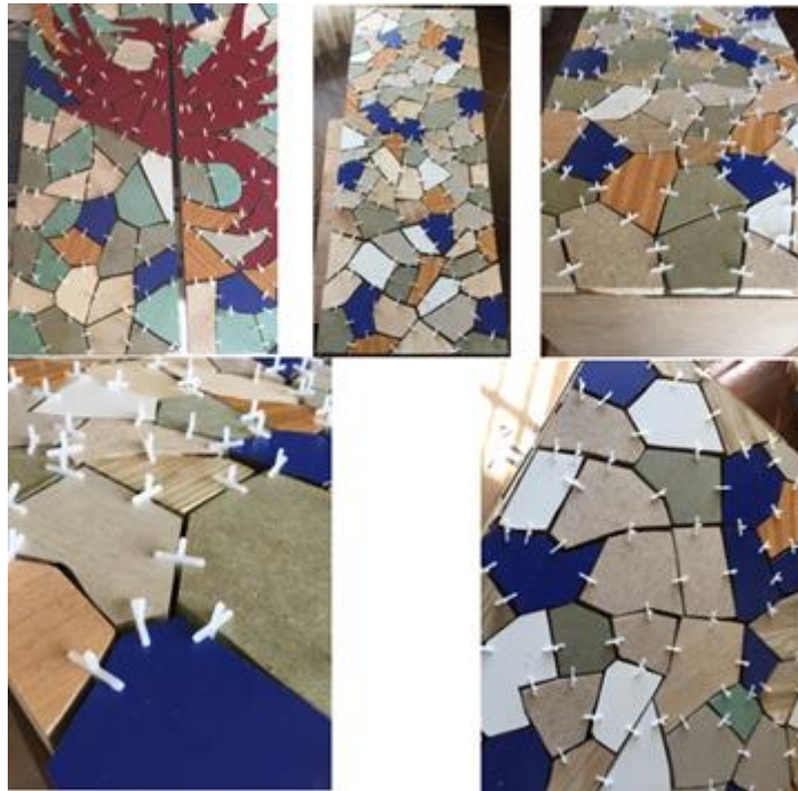
Figura 100 - Colagem das peças, com separadores de 2mm. Fonte: Autora.
