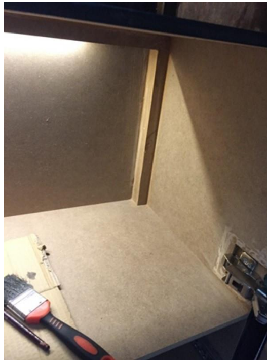
Figura 120- Aplicação da madeira no interior, para ocultar a fita de LED. Fonte: Autora.
