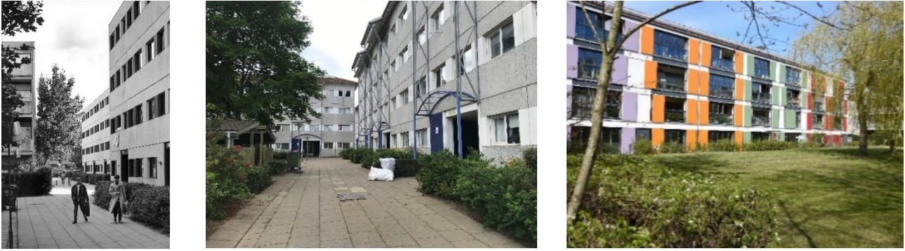
FIGUR 5. Tv. Bebyggelsen i Gadehavegård med de oprindelige flade tage og rå betonmoduler. KILDE: Byhistorisk Samling og Arkiv i Høje-Taastrup Kommune. Midtfor. Bebyggelsen efter renoveringerne i 2000 med tage med en let hældning og et mindre udhæng over indgangspartierne. Th. Blok 9 efter renoveringerne i 2014 med ny klimaskærm med glasinddækkede altaner og farvede vinduesskoder.
