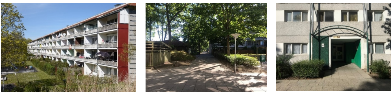
FIGUR 8. Tv. Boligblok set fra altansiden, hvor altanværnene i struktureret beton er misfarvede. Midtfor: Beplantningen fremhæves som en kvalitet, men skaber også potentielt utrygge steder og gør det svært at orientere sig i bebyggelsen. Th. Indgangsdørene i boligblokkene er trukket tilbage i facaden, hvilket skaber en mørk og uoverskuelig zone.
