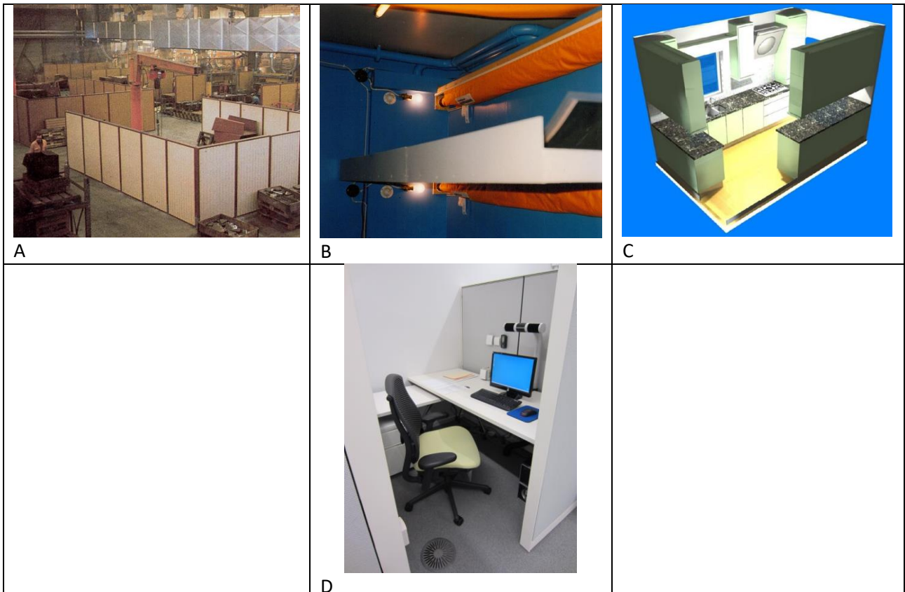
Figur 7. A) En afskærmning af en arbejdsplads med skærme der tilfører friskluft. B) I midten en installation hvor der tilføres luft individuelt til køjer C) Til højre et åbent køkken hvor udsugningen skaber undertryk. D) Celle i kontorlandskab med personlige ventilation.
