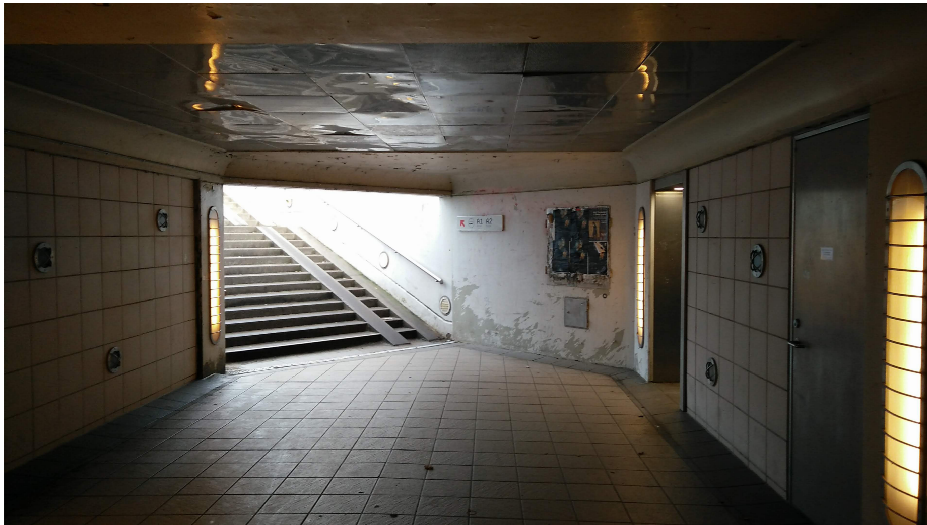
Fodgængertunnelen under Aalborg Banegård. Foto: Søren Risdal Borg.
