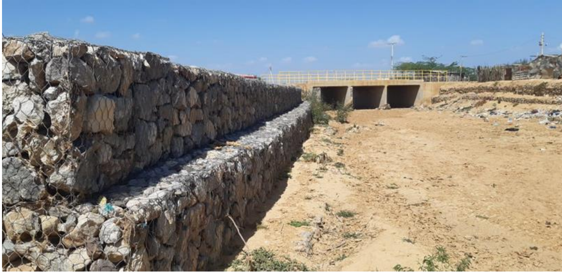
Fotografía 96. Arroyo Chemerrain, Barrio Villa Fausta. Proyecto realizado en 2018, construcción de gaviones
