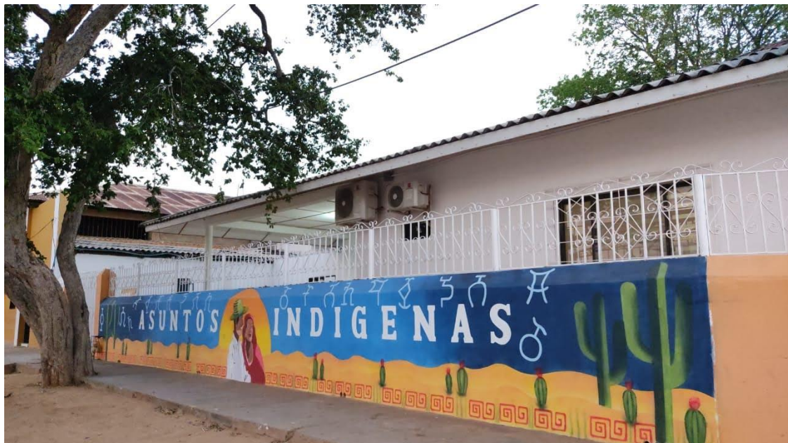
Fotografía 59. Fachada secretaria de asuntos Indígenas municipal. Fuente: Autoría propia
