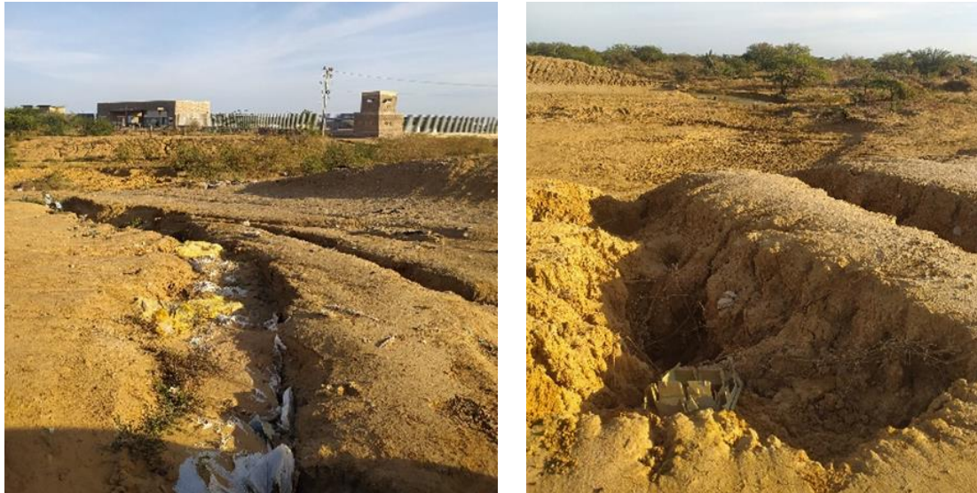
Fotografía 98. Erosión a causa de inundaciones. Barrio Villa Fausta. Fuente: Autoría propia
