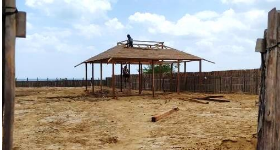
Fotografía 22. Construcción ranchería tradicional Wayúu. Fuente: Autoría Propia
