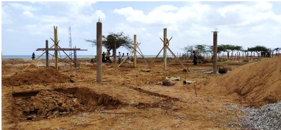
Fotografía 23. Cimentación ranchería tradicional Wayúu. Fuente: Autoría Propia
