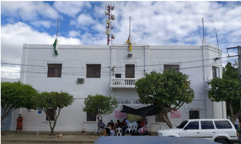
Fotografía 43. Edificio Alcaldía Municipal. Fuente: Autoría propia
