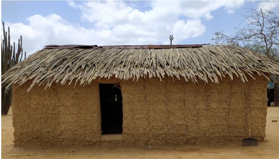
Fotografía 7. Vivienda tradicional Wayúu, ubicada en Ranchería. Fuente: Autoría Propia
