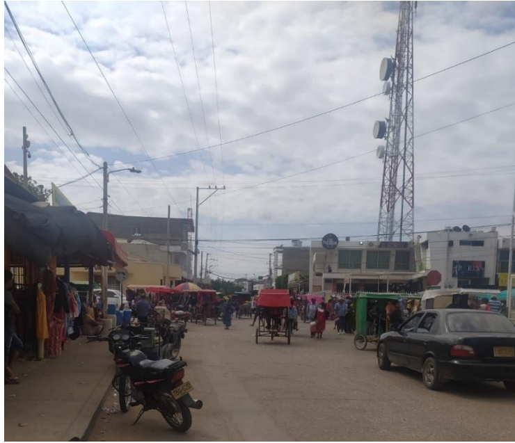
Fotografía 79. Ocupación de espacio público sector “Mercado Las Pulgas” Fuente: Autoría Propia
