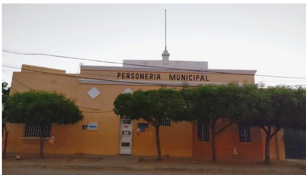
Fotografía 44. Edificio Personería Municipal. (Antiguo edificio PROAGUAS) Fuente: Autoría propia.
