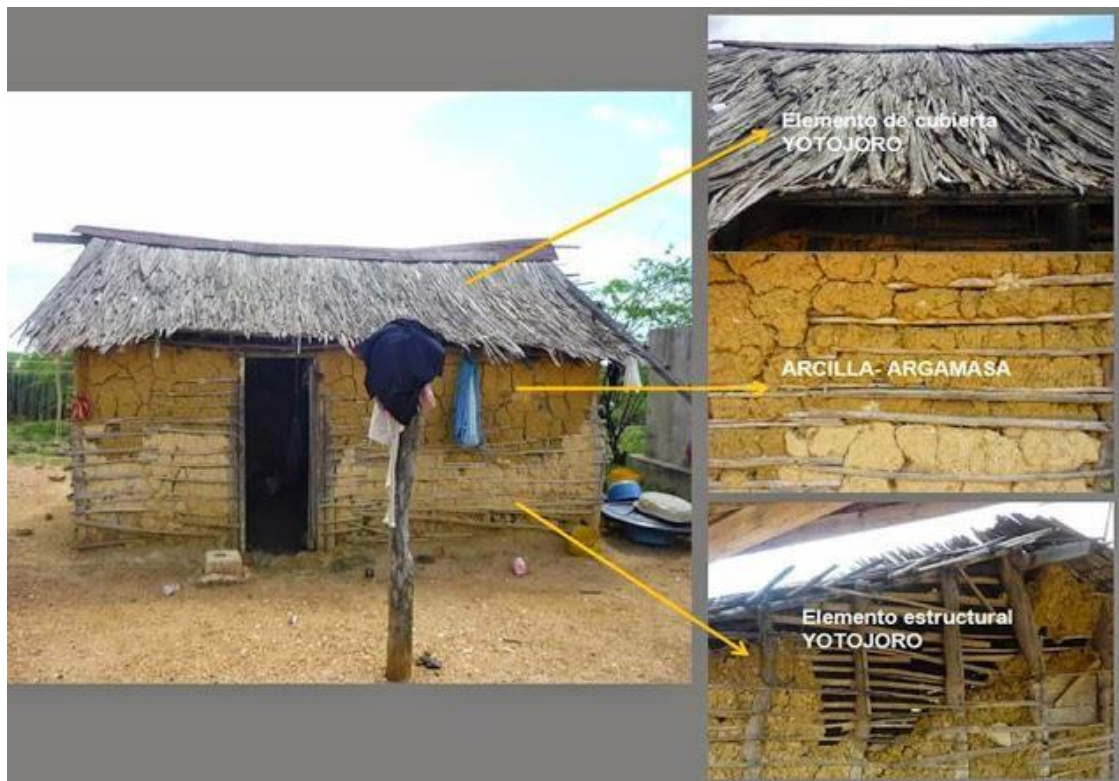
Fotografía 21. Arquitectura vernácula de los indígenas Wayúu – Materiales de construcción
