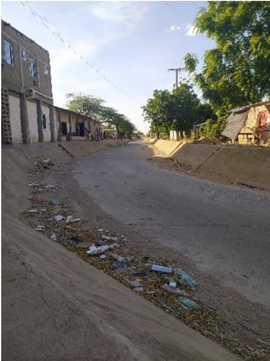
Fotografía 103. Canal doble, Barrio Patio Bonito Fuente: Autoría propia
