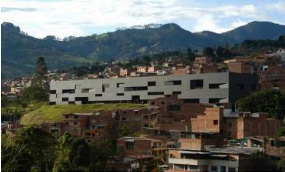
Figura 10. Vista exterior biblioteca Fernando Botero.
