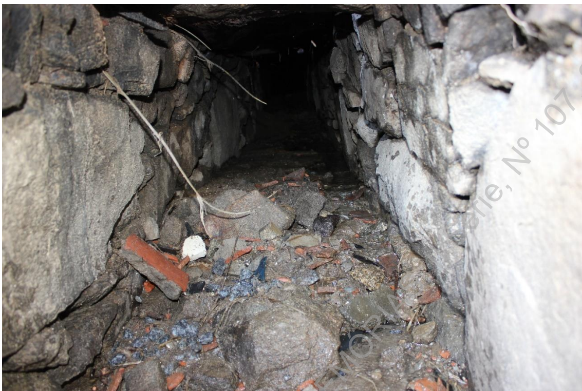
Foto 11 (IMG_7080) – Aspeto do interior da canalização.
