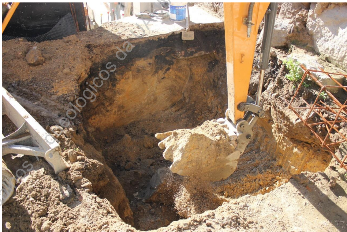
Foto 16 (IMG_9839) – Acompanhamento da abertura mecânica da sondagem 2.
