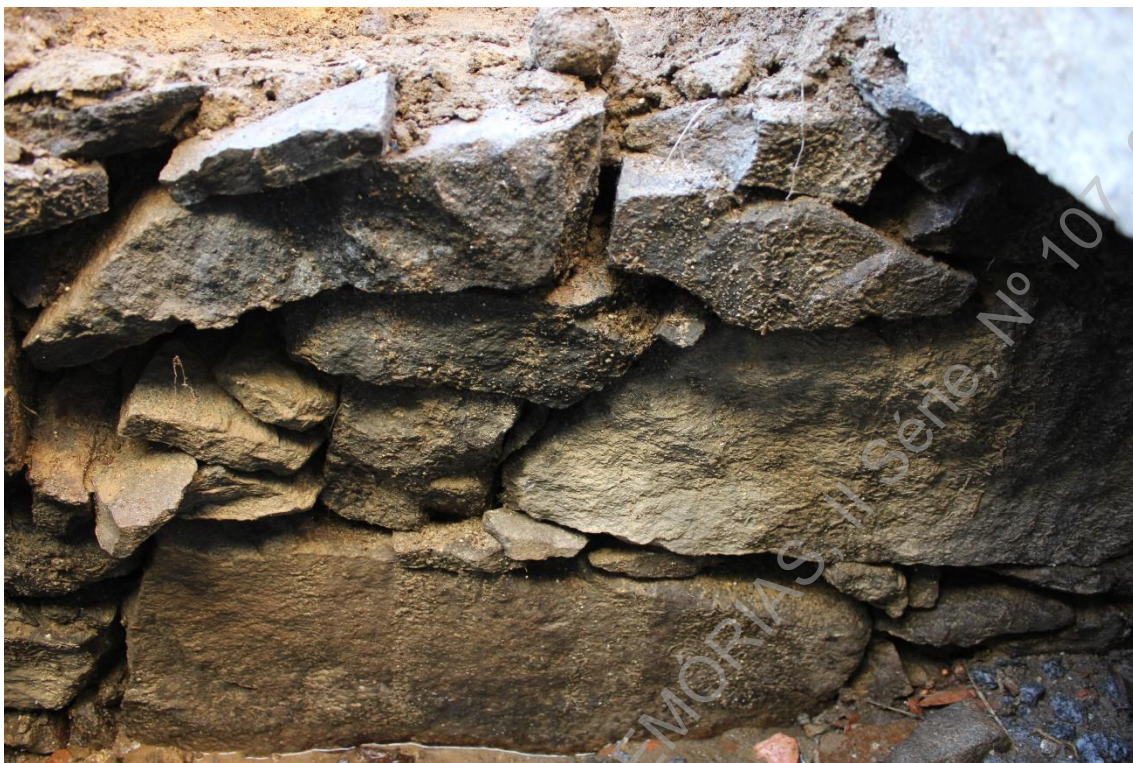
Foto 9 (IMG_7107) – Pormenor do alçado oeste UE003 da canalização.
