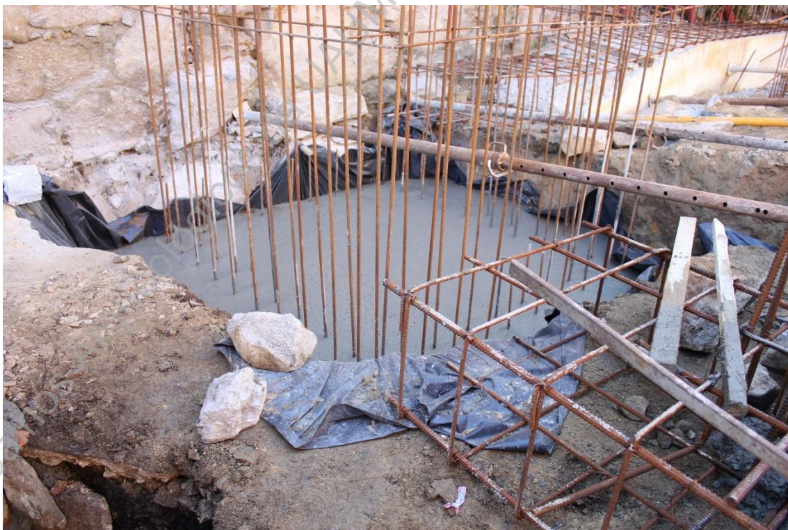
Foto 22 (IMG_0062) – Acompanhamento da betonagem da sondagem 2.
