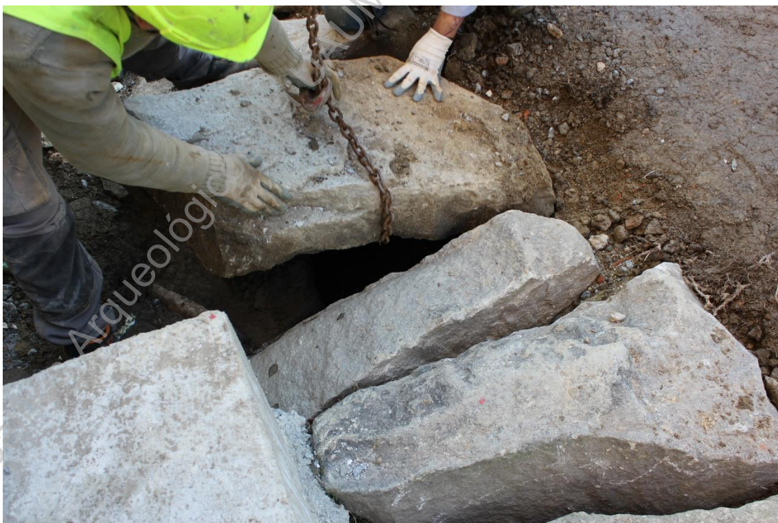
Foto 12 (IMG_7115) – Acompanhamento da reposição da cápea.
