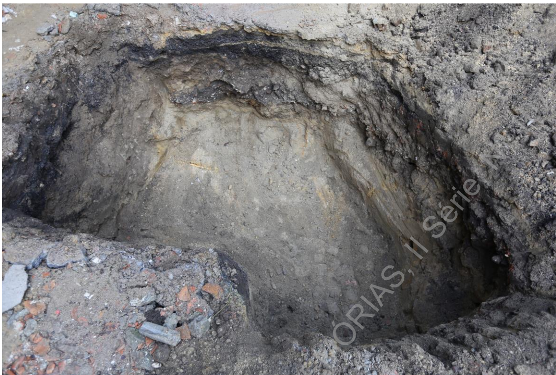
Foto 27 (IMG_1783) – Aspeto final da vala para implantação das caixas de saneamento.
