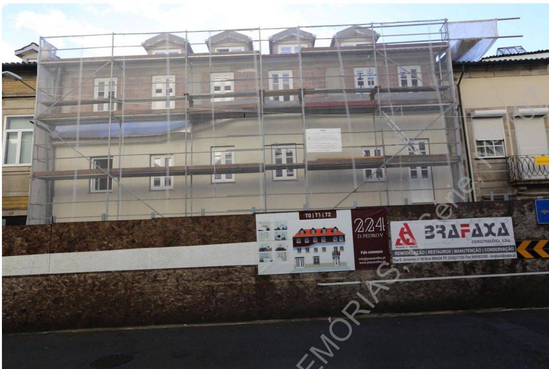
Foto 1 (IMG_1844) – Fachada do edifício localizado nos n.ºs 224-226 da Rua D. Pedro V.
