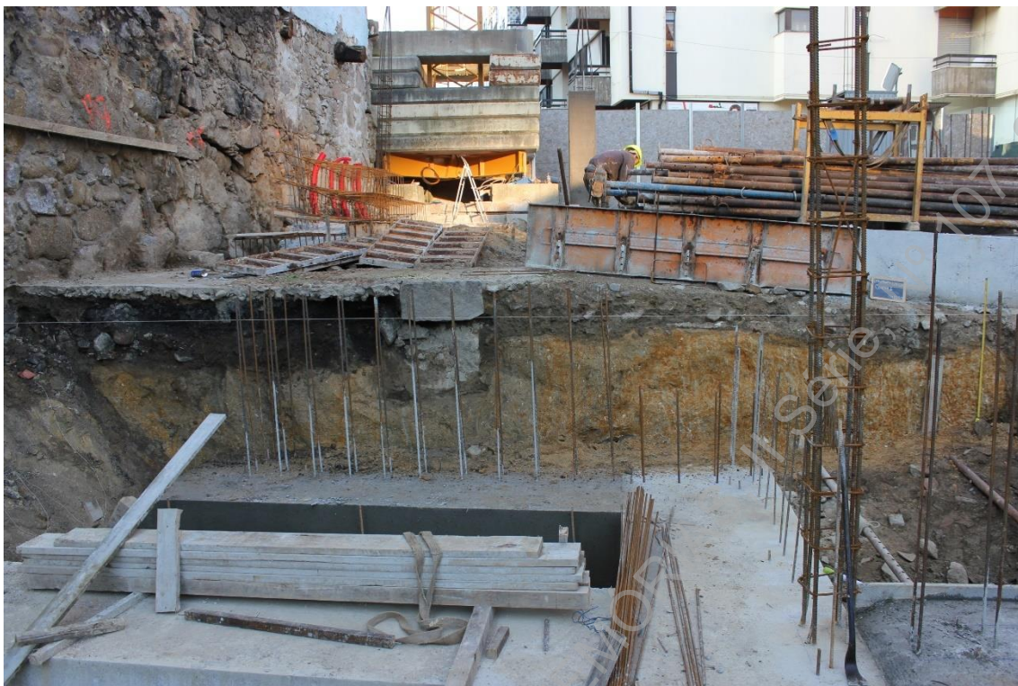
Foto 25 (IMG_6880) – Corte 1, sondagem 3.
