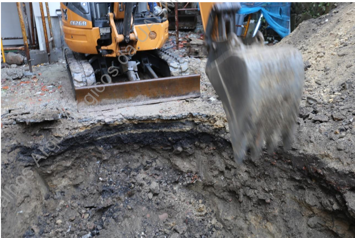
Foto 26 (IMG_1779) – Abertura mecânica da vala para implantação das caixas de saneamento.
