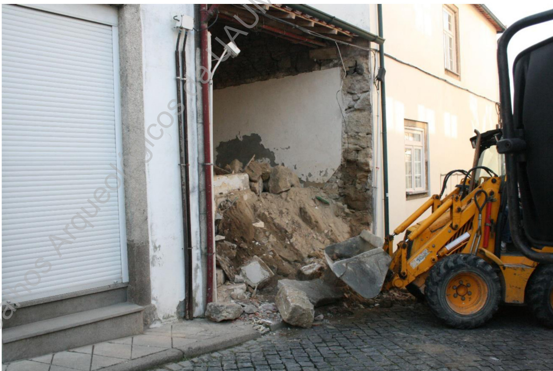
Foto 4 (IMG_2008) – Acompanhamento dos trabalhos de demolição da fachada da habitação.
