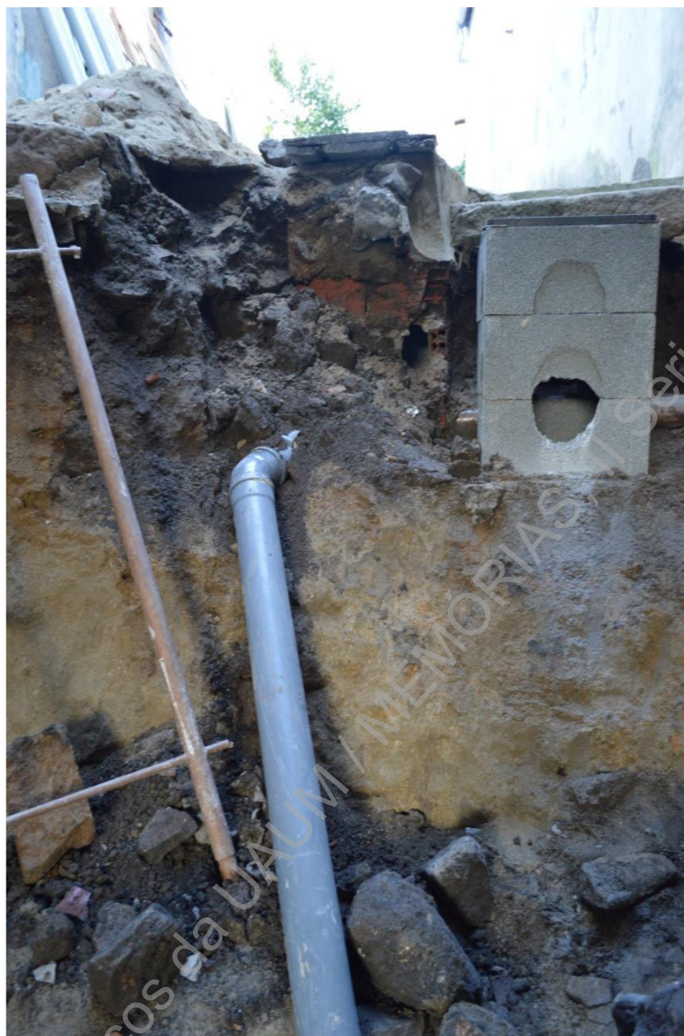
Foto 7 (DSC_2595) – Pormenor de instalação de caixa de saneamento.
