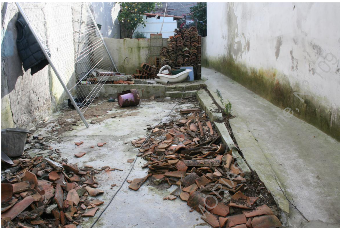
Foto 3 (IMG_1947) – Perspetiva geral da área de logradouro da habitação.
