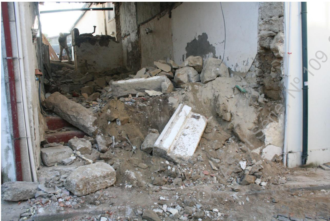
Foto 5 (IMG_2013) – Início dos trabalhos de demolição da habitação.
