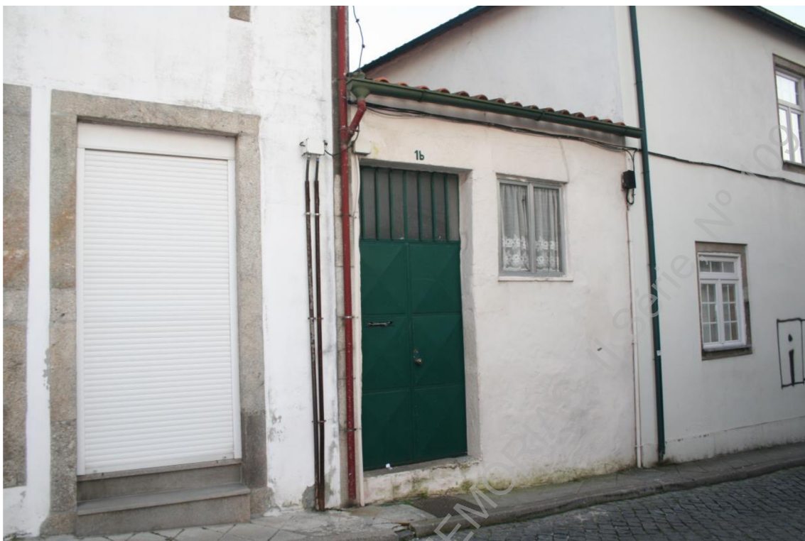
Foto 1 (IMG_1917) – Fachada do edifício localizado no nº 16 da Rua de São Domingos.
