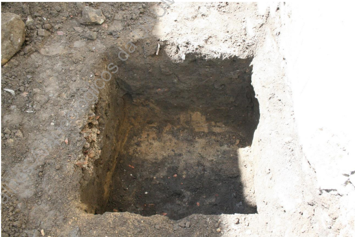
Foto 12 (IMG_2405) – Pormenor da abertura de sapatas.
