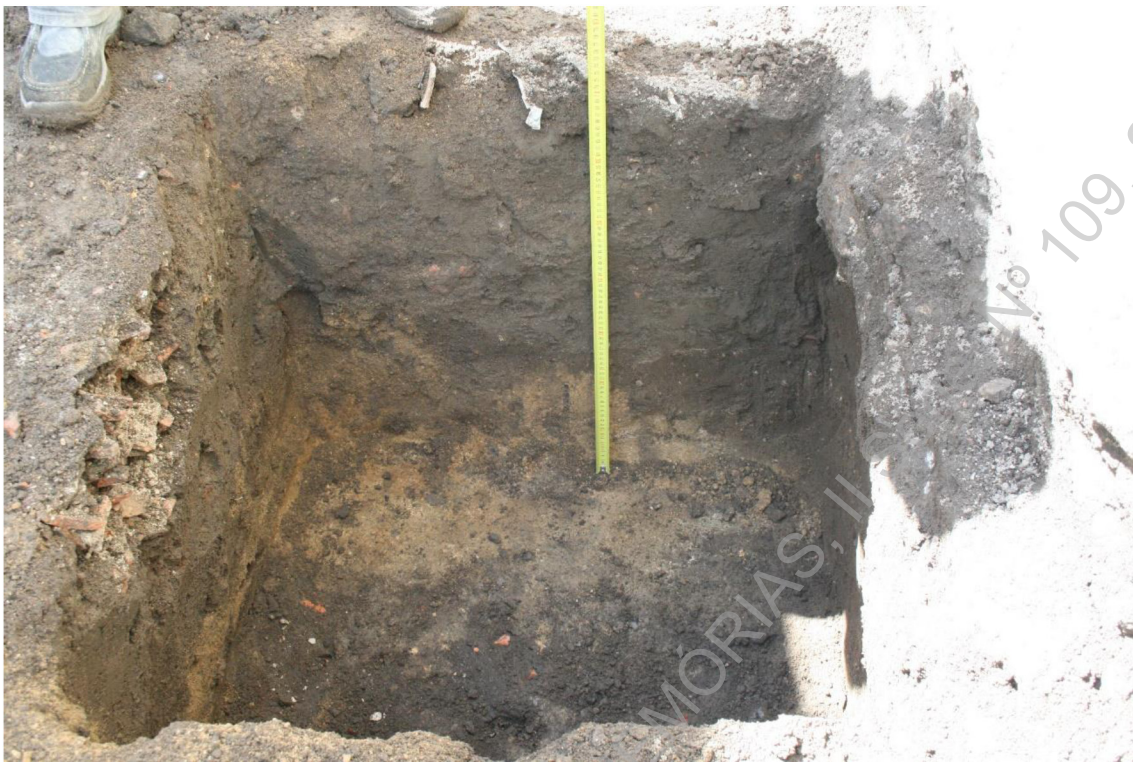
Foto 13 (IMG_2426) – Pormenor da abertura de sapatas.
