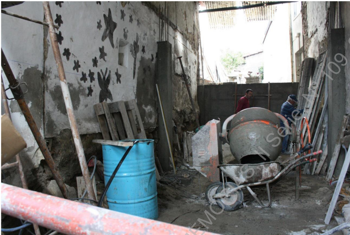
Foto 11 (IMG_2385) – Perspetiva geral da área intervencionada com pilares e muro em betão armado.
