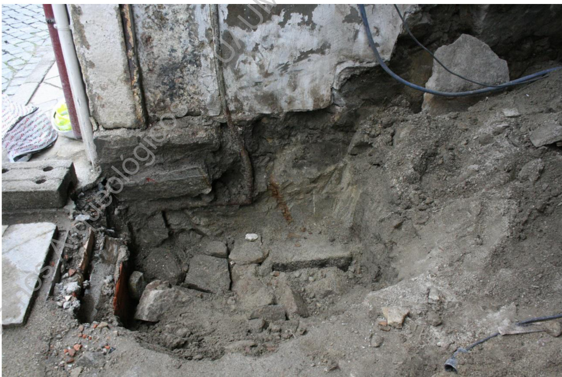
Foto 9 (IMG_2361) – Acompanhamento da abertura de valas para colocação de pilares.
