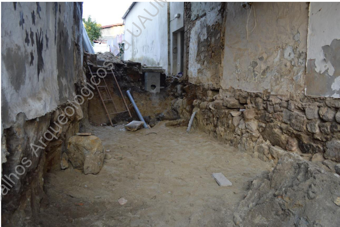
Foto 6 (DSC_2568) – Aspeto geral do trabalho de desaterro.
