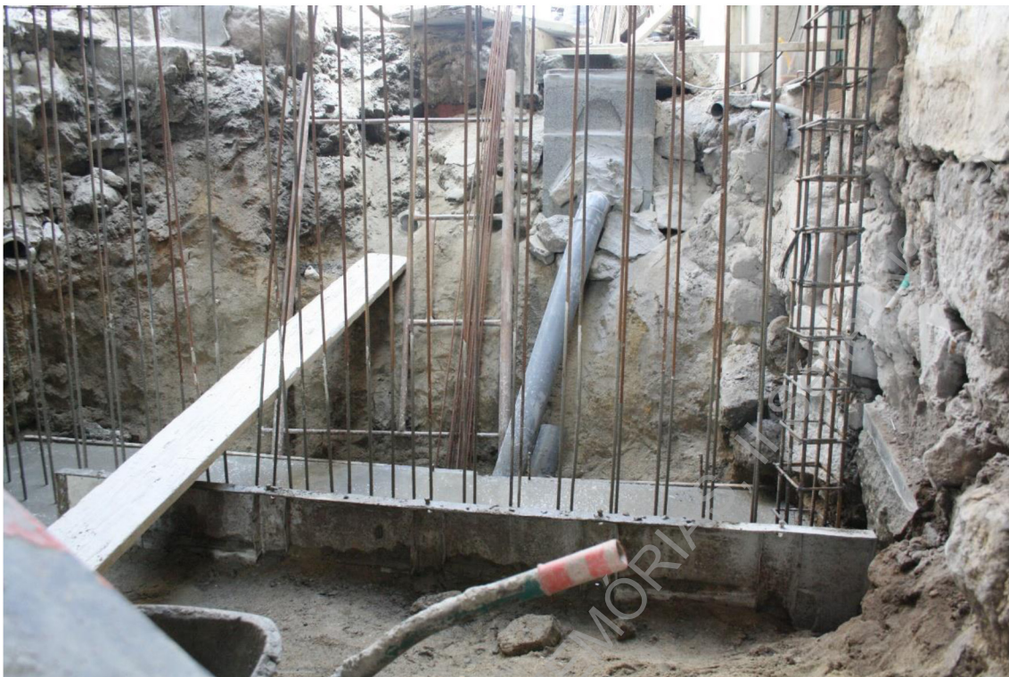
Foto 8 (IMG_2317) – Acompanhamento dos trabalhos de betonagem da sapata do muro para segurar as terras do logradouro.
