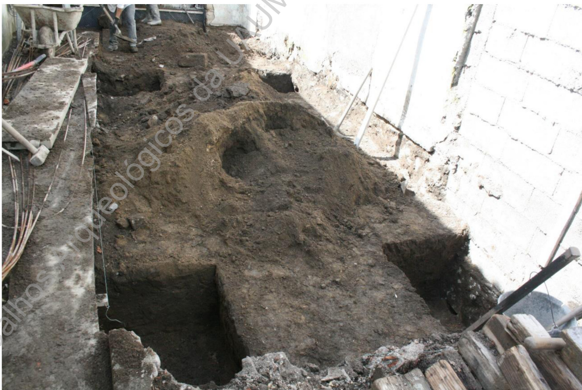
Foto 14 (IMG_2411) – Perspetiva geral da abertura de sapatas na área do logradouro da habitação.
