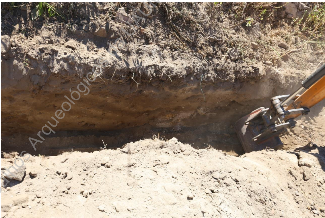
Foto 2 (IMG_9695) – Acompanhamentos dos trabalhos de decapagem na avenida Artur Soares, nº 687.
