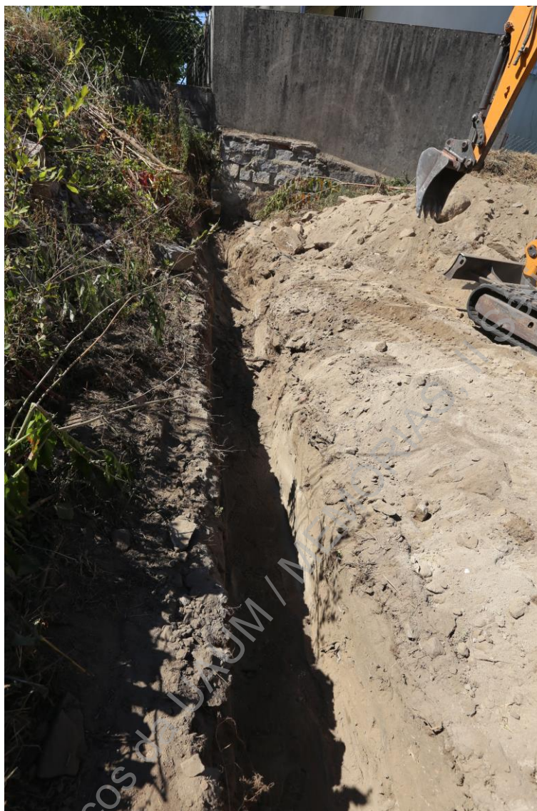
Foto 3 (IMG_9716) – Perspetiva da vala para implantação do muro de contenção das terras.
