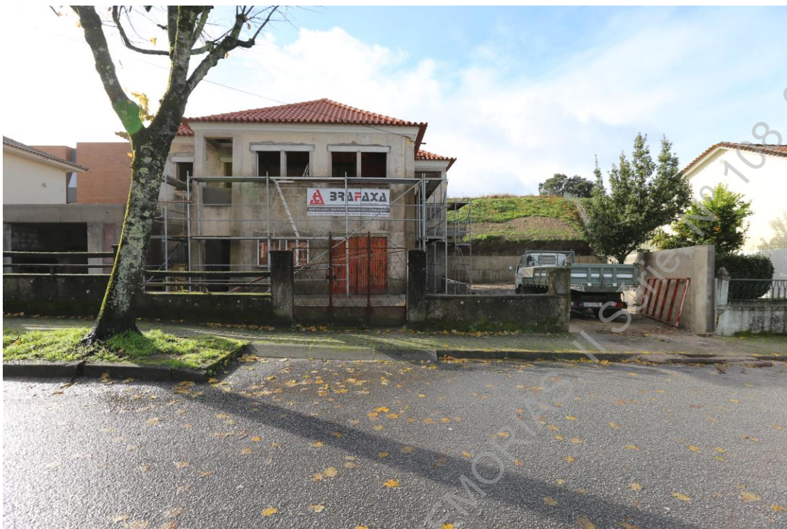
Foto 1 (IMG_1873) – Fachada do nº 687 da avenida Artur Soares.
