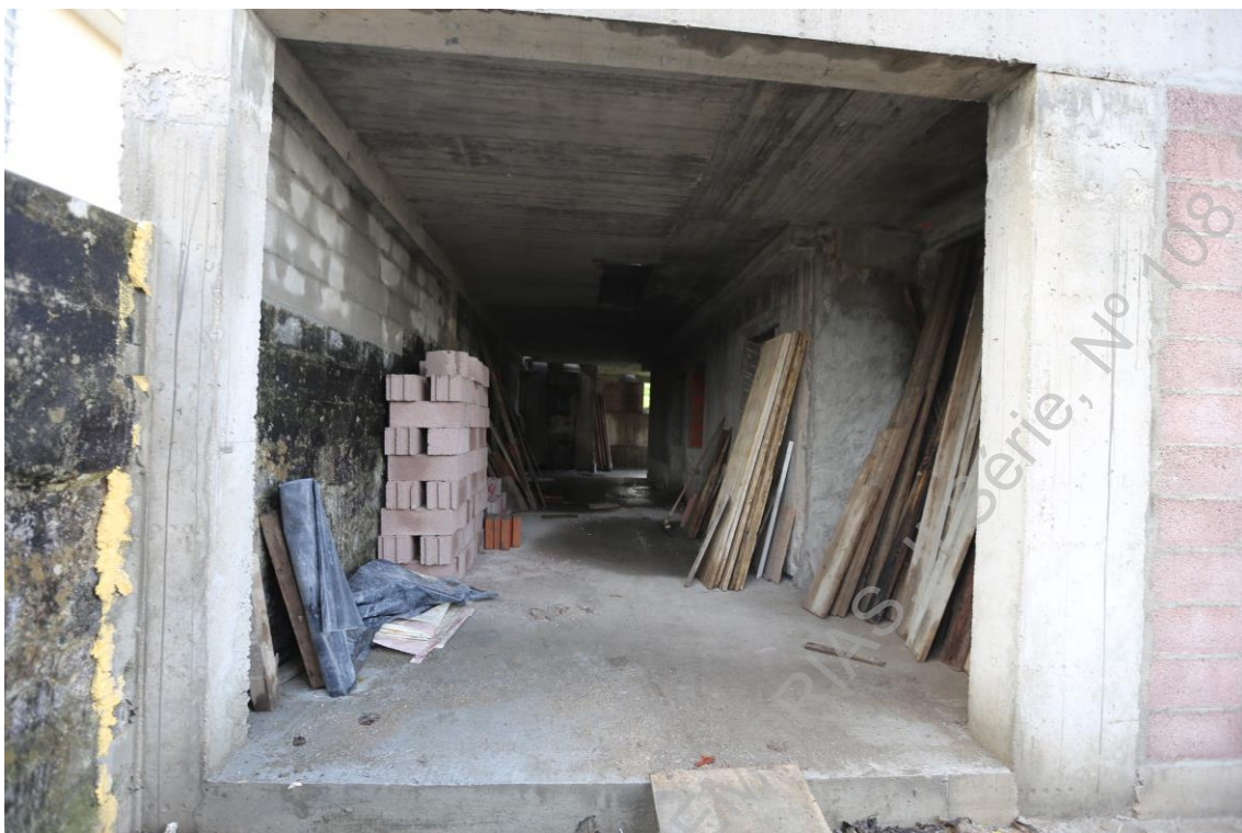
Foto 7 (IMG_1886) – Acompanhamento dos trabalhos de construção da garagem.
