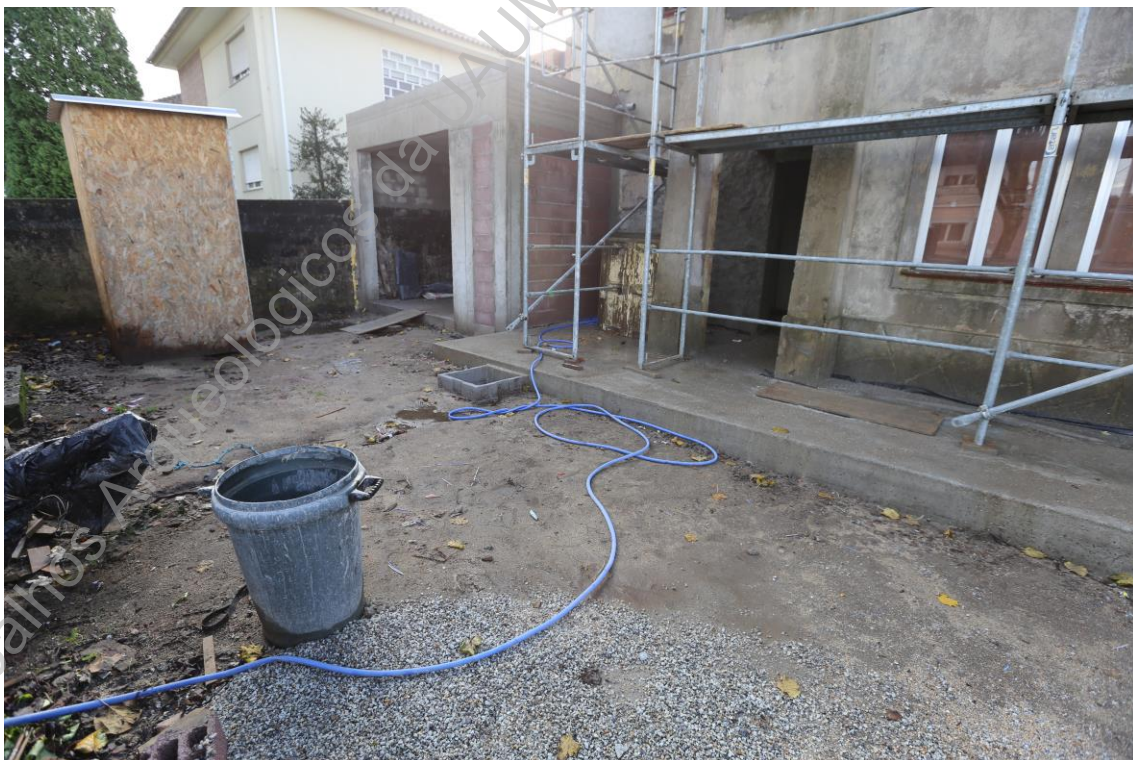
Foto 8 (IMG_1892) – Acompanhamento dos trabalhos de construção da garagem.
