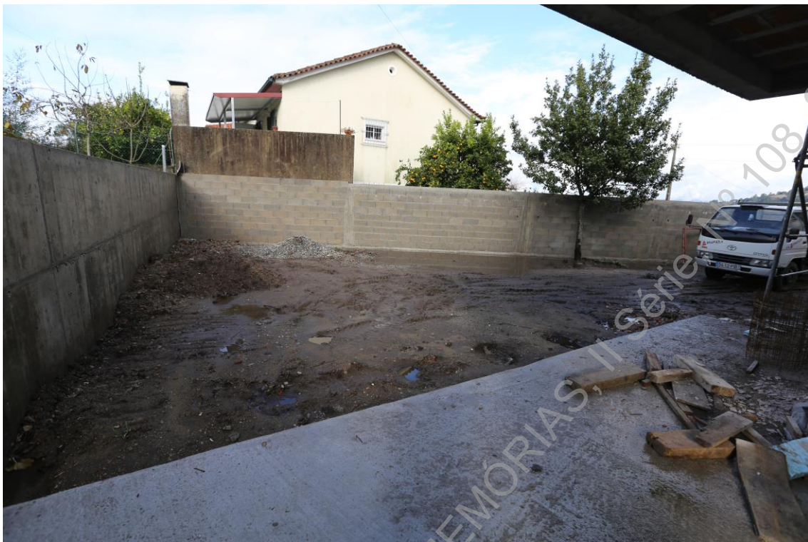
Foto 5 (IMG_1880) – Muro de contenção de terras e do limite norte do lote.
