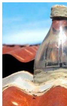
Figura 71: visualização externa de garrafa PET com água, fixada no telhado.
