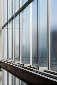
Figura 106: Detalhe da luminária Tubo Evo instalada na viga metálica.
