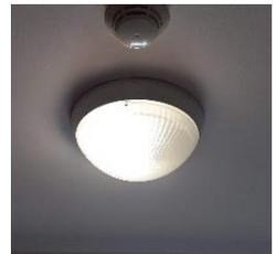
Figura 167: destaque luminária instalada diretamente na laje.
