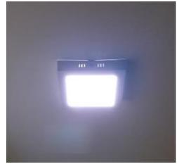
Figura 165: destaque luminária instalada diretamente na laje.
