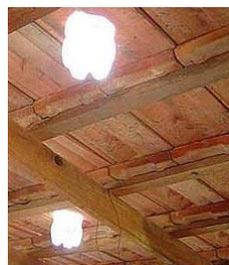
Figura 72: visualização interna de garrafa PET com água, fixada no telhado.
