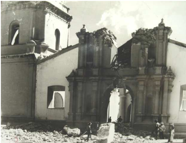
Figura 2. Demolición de La Concepción. Detalle. Fuente: Archivo Audiovisual Diario El Impulso , Barquisimeto
