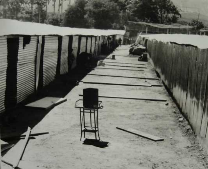
Figura 8. Campamento de casas provisionales. Fuente: Archivo Audiovisual Diario El Impulso, Barquisimeto
