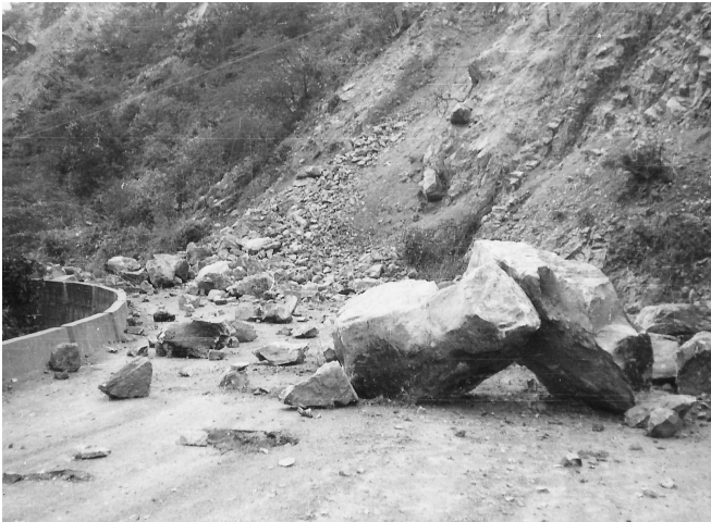
Figura 4. Derrumbes en la carretera El Tocuyo-Guarico. Fuente: Deno y Bushman, 1950
