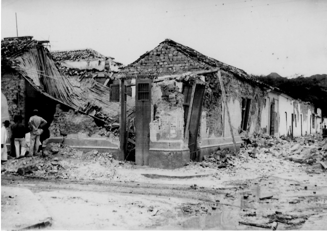
Figura 1. Casas destruidas en una calle de El Tocuyo Fuente: Dengo y Bushman, 1950
