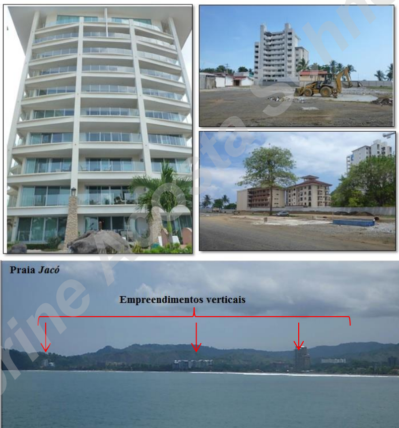
Foto 22 - Exemplos de verticalização residencial na última década em Jacó , província de Puntarenas (litoral Pacífico da Costa Rica)
