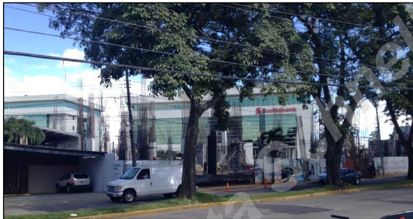
Foto 32 - Novo empreendimento vertical em construção no bairro de alto padrão, Rohrmoser, dezembro 2013.
