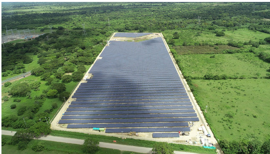
Ilustración 3, Granja solar en el departamento de Bolívar. Instalada por Celsia
