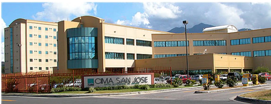
Imagen #11: Hospital Cima San José Santa Ana (Fuente: www.hospitalcima.com )
