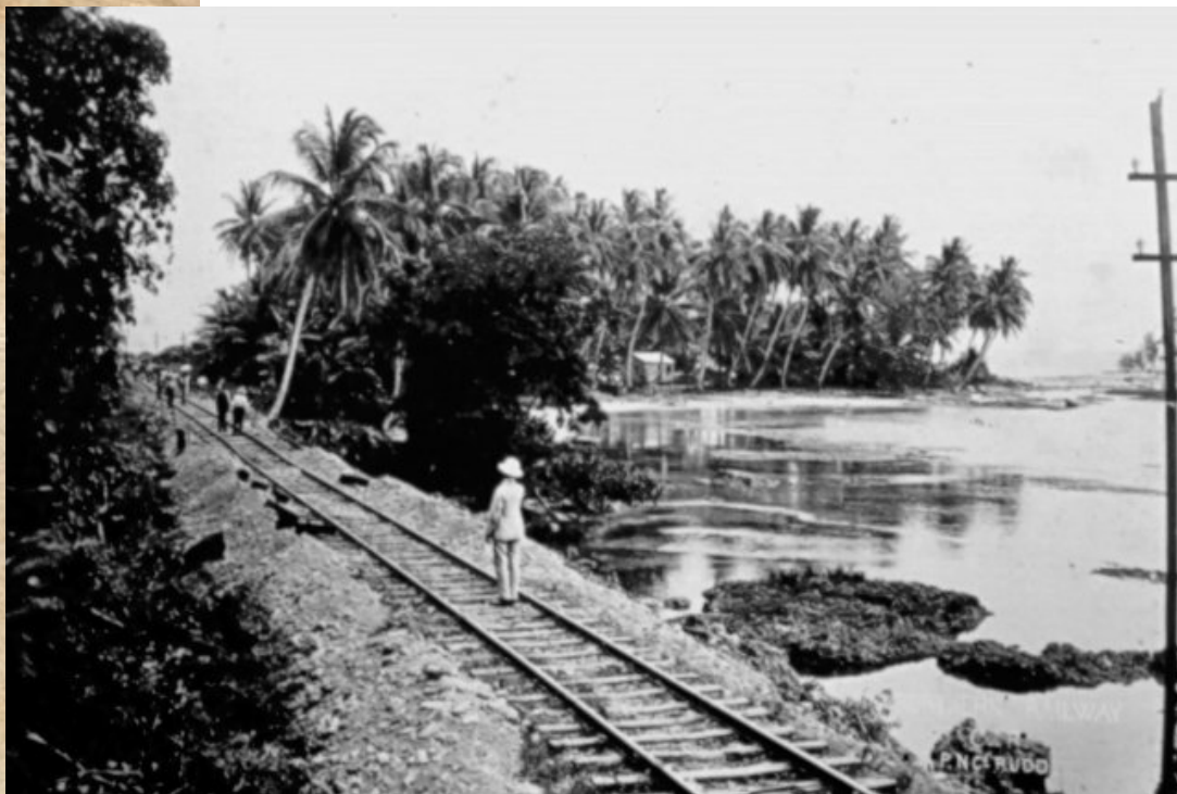
Línea del Ferrocarril Northern Railway Company, 1890. Álbum Harrison Nathaniel Rudd, Colección CIHAC.
