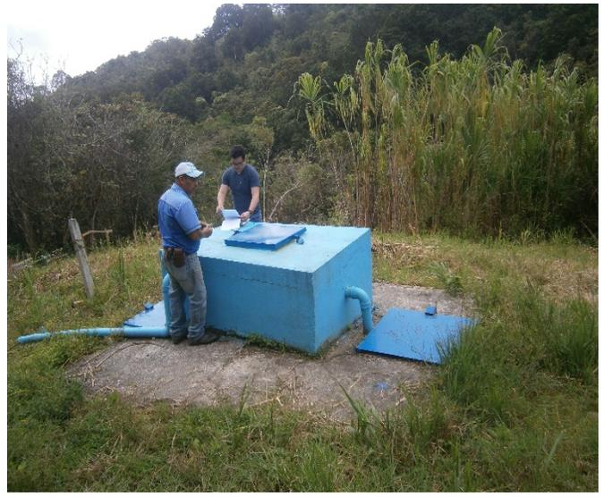
Foto 2. La estructura de los tanques quiebra gradiente debe estar debidamente pintada y limpia. LA tapa con seguro. Disponer borde de cemento alrededor del tanque de al menos 0,80 metros. En este caso se recomienda disponer de una malla perimetral para garantizar seguridad.
