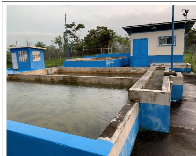
Foto 1. Planta de potabilización de agua de tecnología Filtración Múltiples Etapas FiME. Sistema muy apropiado para poblaciones pequeñas, no se requiere el uso de compuestos químicos para la coagulación.
