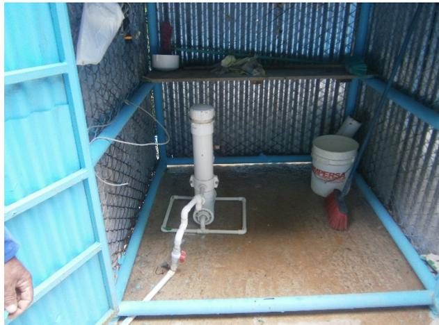
Foto 3. El sistema de cloración debe ubicarse en un sitio que disponga con ventilación e iluminación natural. El sistema de cloración deben disponer de un caudalímetro para medir el flujo de la solución de cloro aplicada al caudal debidamente medido del agua cruda de ser desinfectada
