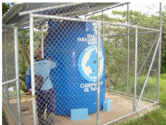
Foto 2. Los tanques de PVC deben disponer de cerramiento perimetral de protección.
