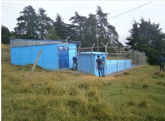
Foto 1. Los tanques de concreto deben disponer de cerramiento perimetral de protección.
