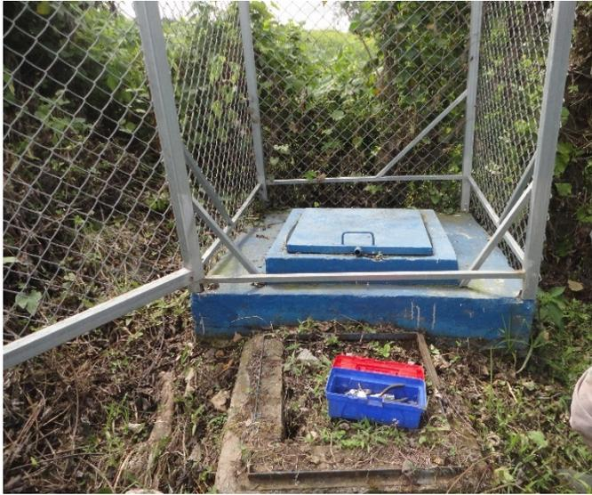
Foto 1. Los tanques quiebra gradientes deben disponer un sistema de seguridad de la tapa, revisados y hacer limpiezas al menos cada mes. Disponer de una distancia prudente de viviendas y tener su cerramiento perimetral.
