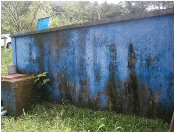
Foto 1. Los muros de los tanques deben ser revisados tanto a su interior como al exterior para establecer la existencia de fugas. Además, se debe tener un borde de cemento alrededor del tanque de un metro de ancho como mínimo.
