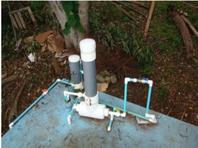
Foto 1. Clorador de construcción casero. No se posee caseta de cloración, no se dispone de caudalímetro de medición de la solución de cloro aplicada.
