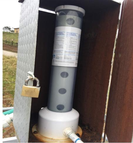
Foto 2. Clorador comercial y patentado, el cual posee su respectivo caudalímetro de medición de la solución de cloro aplicada.
