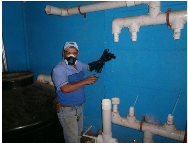
Foto 4. Dotación de equipo de protección del personal que realiza la operación de la desinfección en un acueducto. El lugar donde se localice el clorador debe ser con ventilación e iluminación natural.
