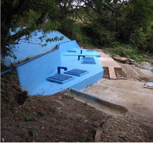
Foto 1. Se posee cobertura en concreto, las tapas bien construidas y seguras, posee el canal por el costado superior para desviar las aguas de escorrentía.
