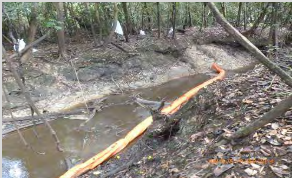
FOTO N° 26: Se observa otro punto del Canal de descarga natural de las aguas del Canal de flotación, se observa fluyendo agua de manera permanente a través de ella hacia el río Cuninico.
