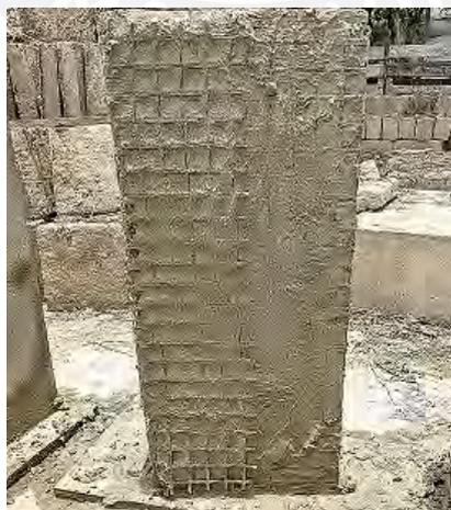
**Figura 5-4. Primera capa de mortero en malla de fibra de basalto.**
