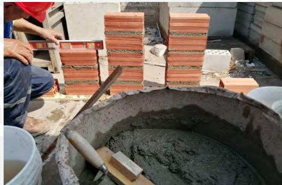
**Figura 5-2. Mortero de para asentado de ladrillo de pila.**
