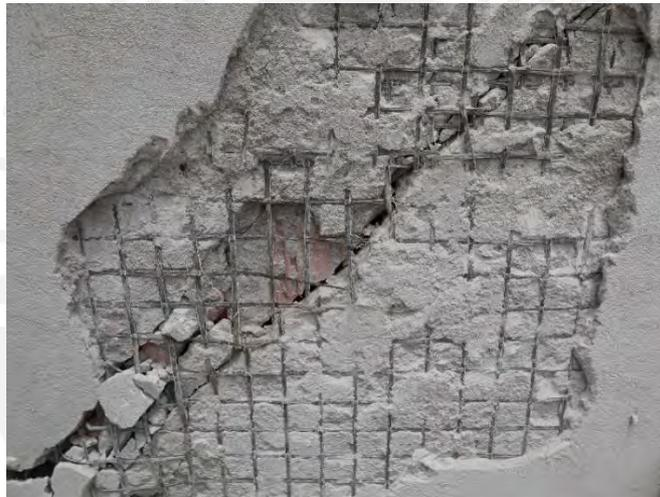
Figura 6-39. Malla aún adherida al mortero de MB-3.
