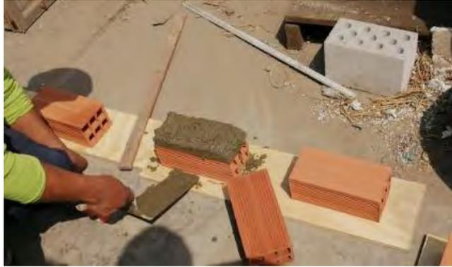
**Figura 5-1. Mortero de para asentado de ladrillo de pila.**
