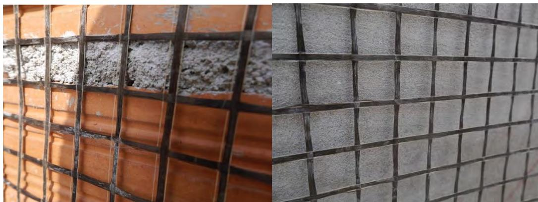
**Figura 4-16. Malla de fibra de basalto**
