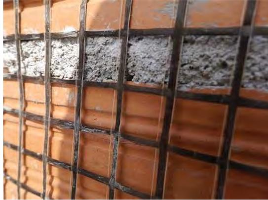
**Figura 5-11. Malla de fibra de basalto.**
