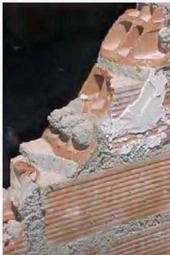
**Figura 2-3. Bloques de mortero formados en el interior de las unidades tubulares. (Salinas y Lázares, 2007).**
