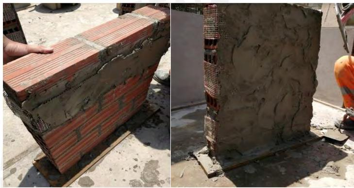
**Figura 5-14. Proceso de reforzamiento con malla de fibra de acero.**
