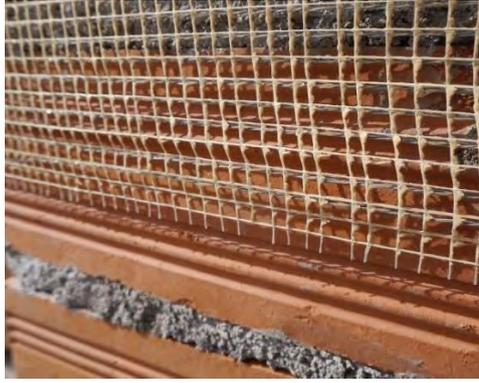
**Figura 5-13. Malla de fibra de acero galvanizado.**
