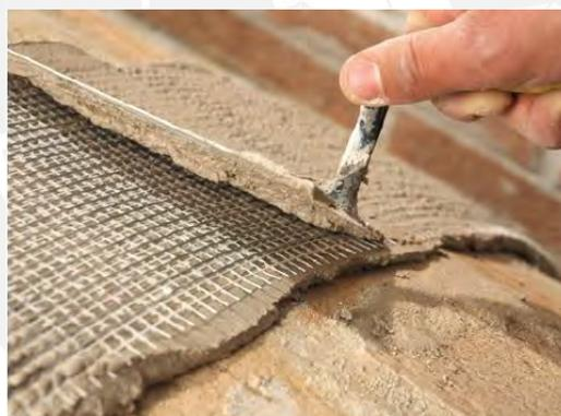
Figura 4-15. Aplicación de fibra de acero galvanizado con mortero GeoCalce (Manual Técnico, 2018).
