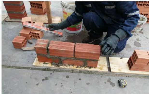
**Figura 5-6. Construcción de segunda hilada de murete.**
