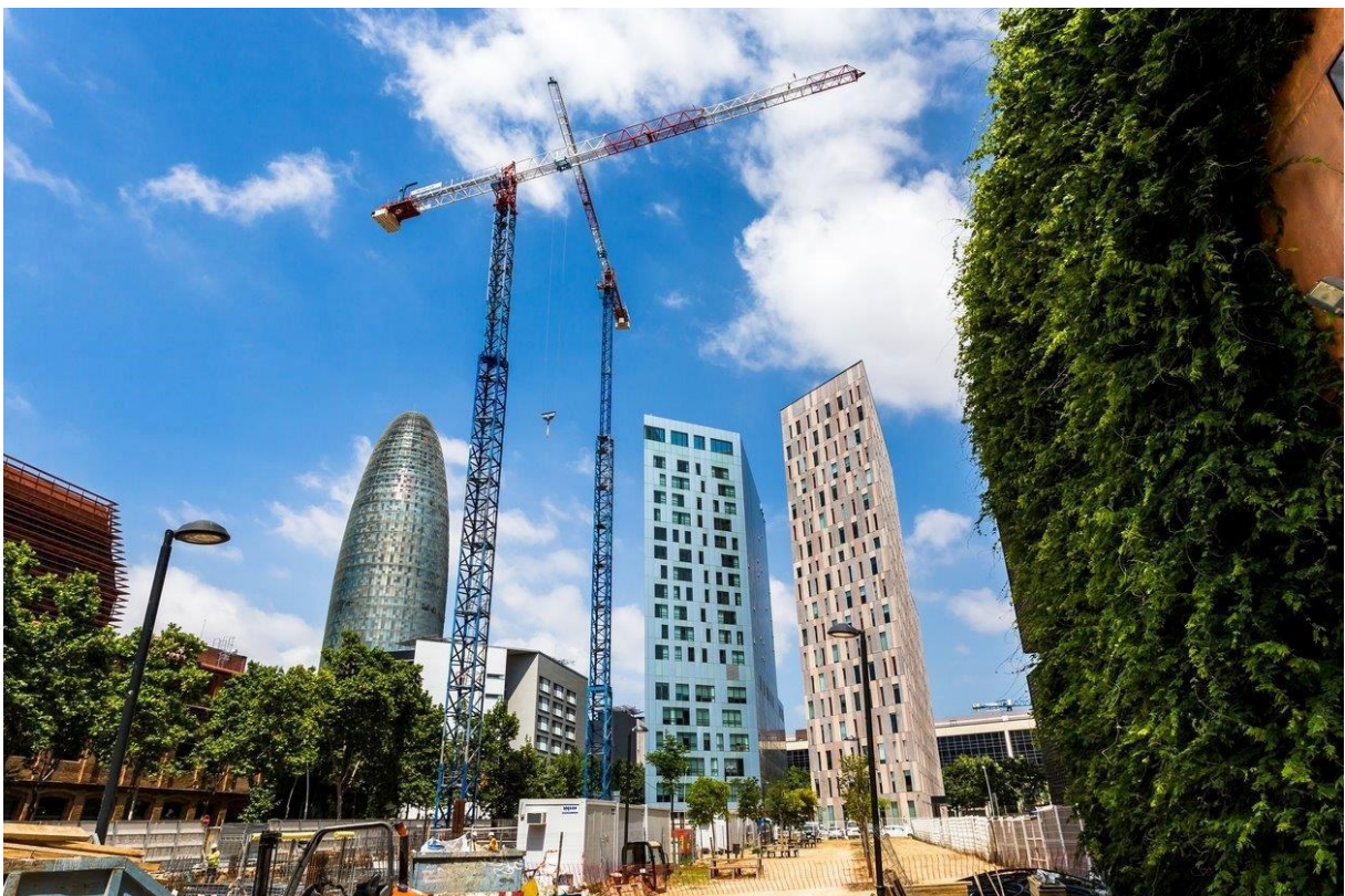
Imagen 6. Edificación en altura en el barrio Poblenou.
