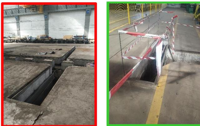
**Figura 9:** Condição insegura vs. Condição segura- Aberturas no pavimento.
