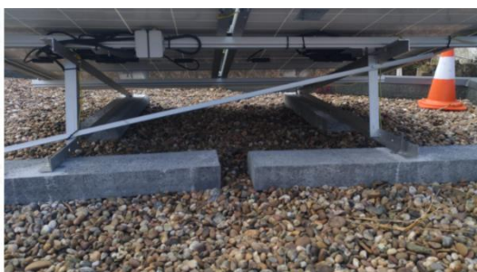
Figura 28 – Estrutura para fixação de painéis tipo triângulo com lancis
