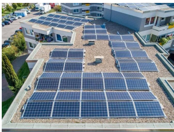
Figura 71 – Gerador com orientações/inclinações distintas (adaptado de [52])
